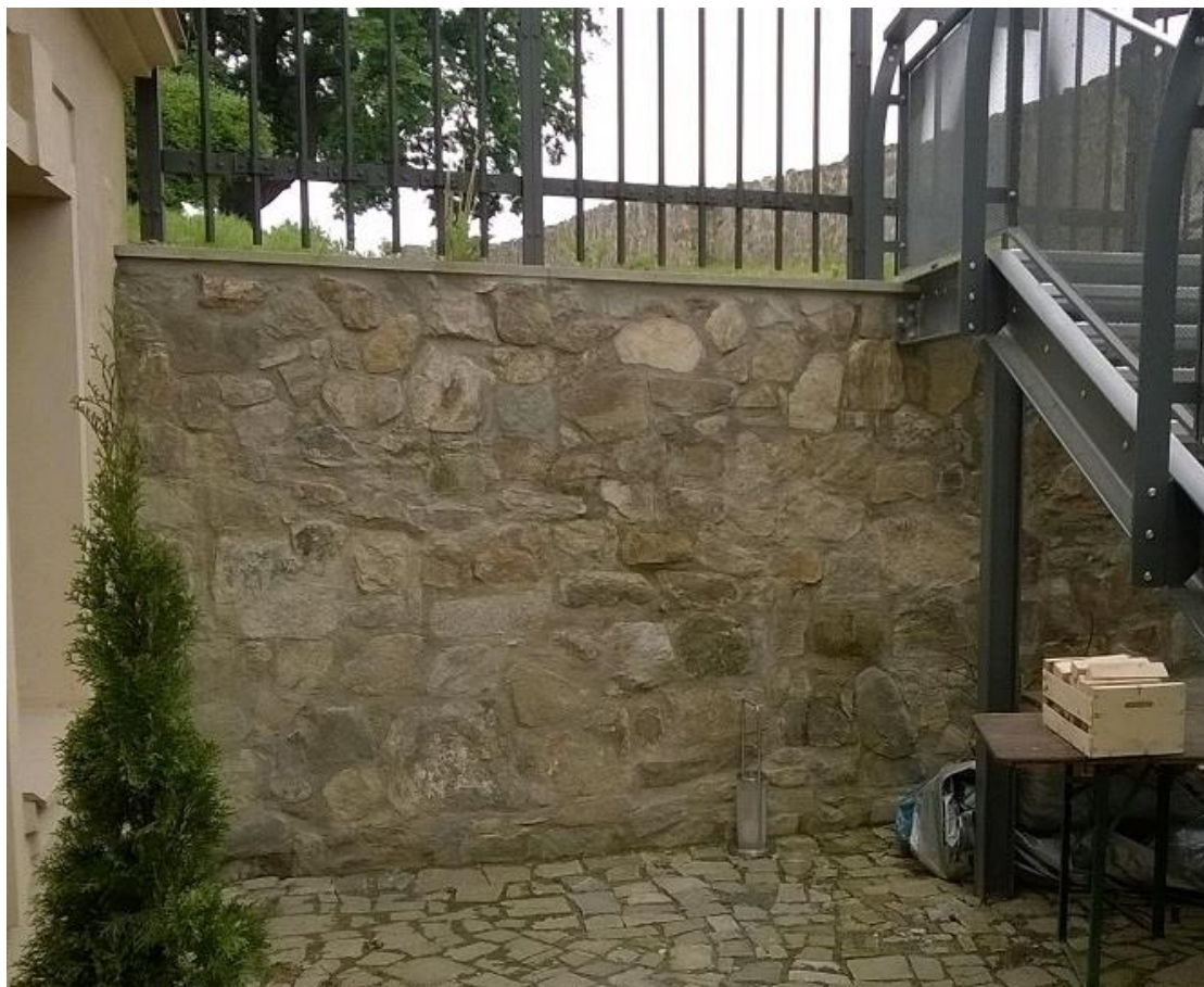
Obrázek 12 - opěrná zeď [vlastní fotografie]
