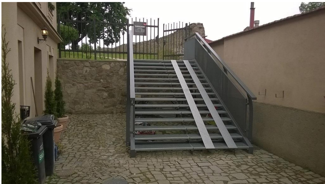
Obrázek 17 - ocelové schody při vstupu na parkán [vlastní fotografie]
