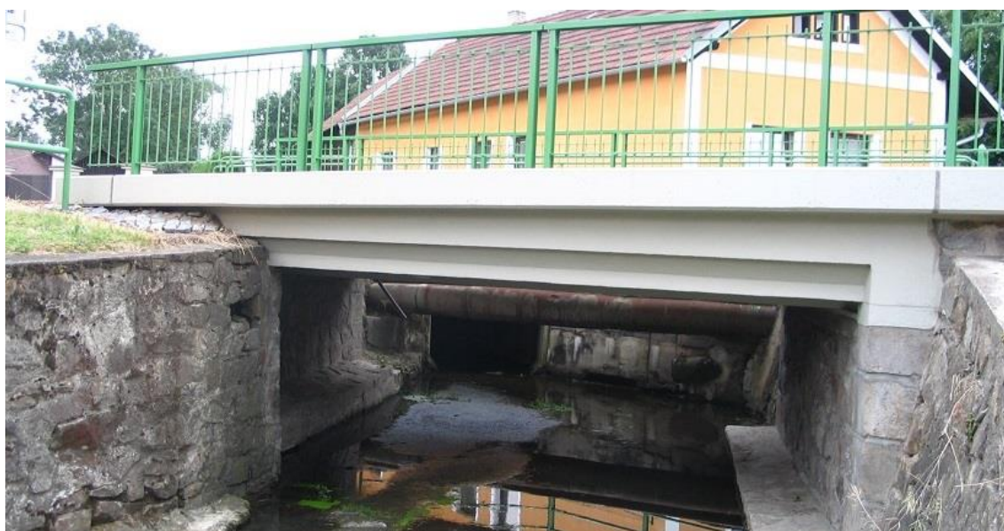
Obrázek 6 – mostovka, římsa a zábradlí [vlastní fotografie]
