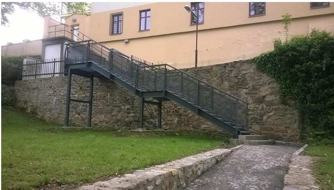
Obrázek 16 - ocelové schodiště, chodník, opěrné zidky [vlastní fotografie]
