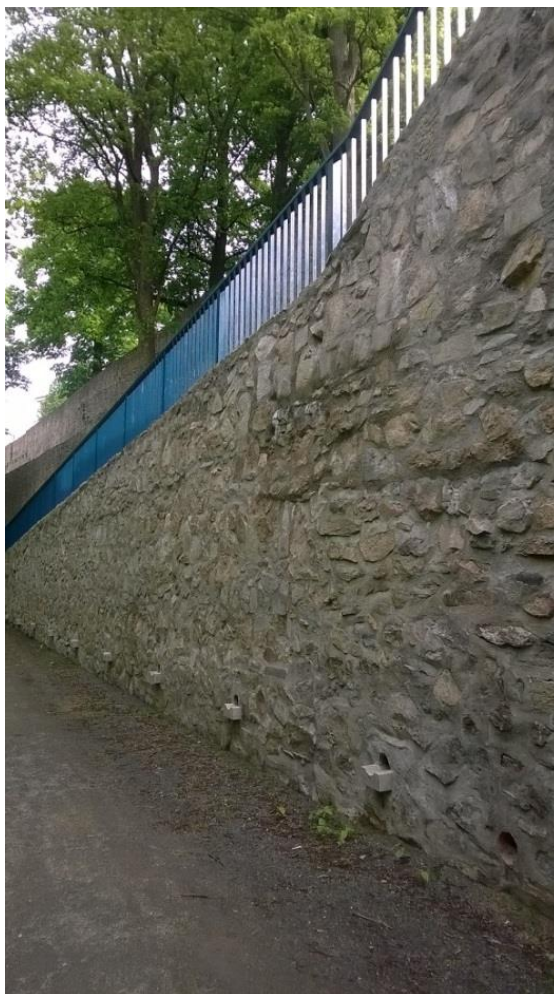
Obrázek 14 - opěrná zeď schodiště [vlastní fotografie]
