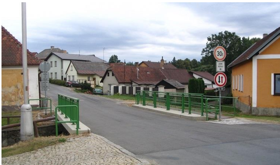
Obrázek 8 - pohled na most po rekonstrukci [vlastní fotografie]
