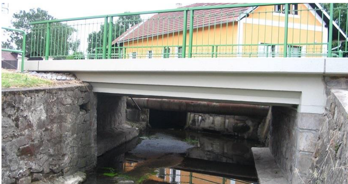
Obrázek 6 – mostovka, římsa a zábradlí [vlastní fotografie]
