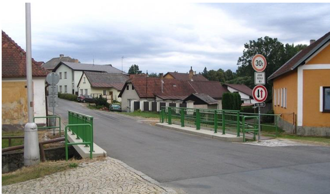
Obrázek 8 - pohled na most po rekonstrukci [vlastní fotografie]
