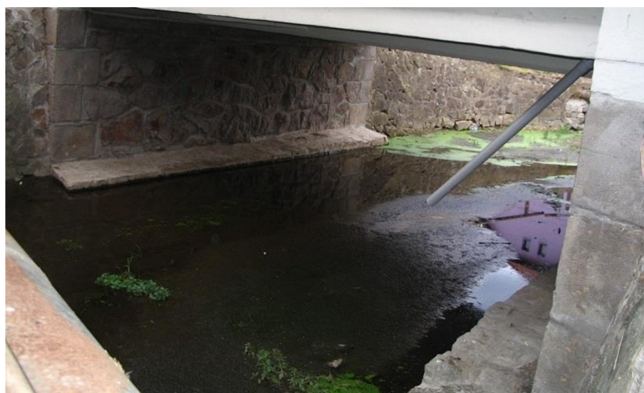
Obrázek 5 - kamenné opěrné zdi [vlastní fotografie]
