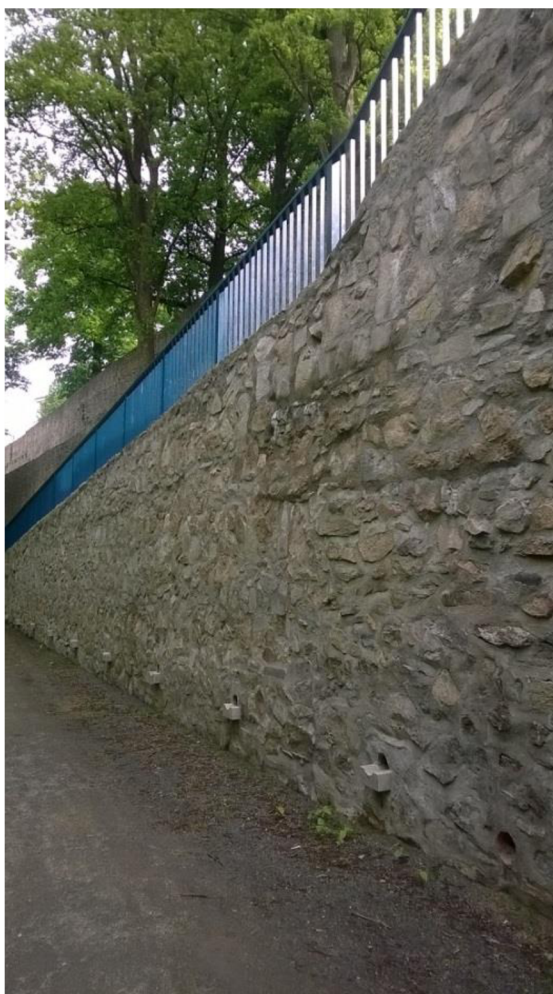
Obrázek 14 - opěrná zeď schodiště [vlastní fotografie]
