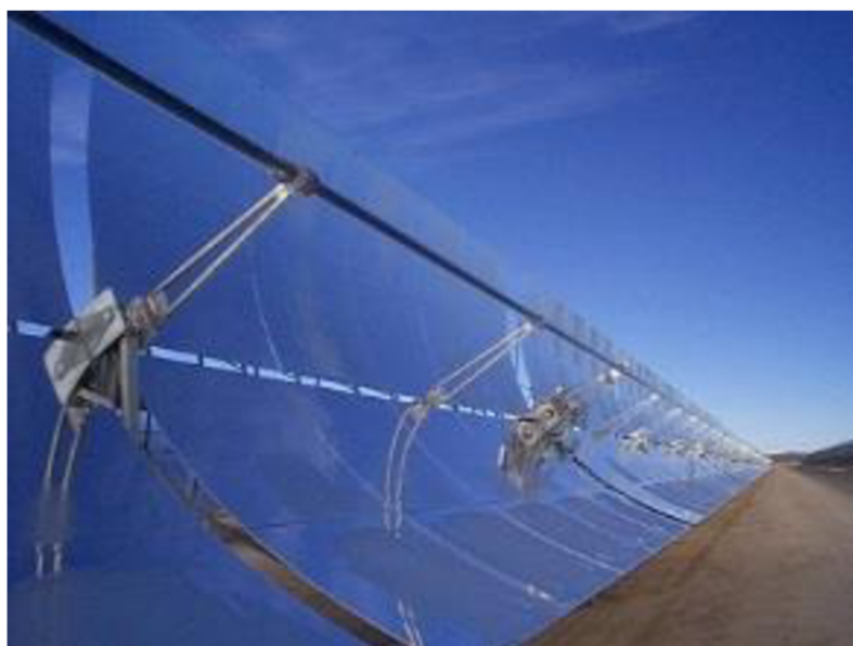
Obrázek 11: Příklad žlabového sběrače FV elektrárny [11]
