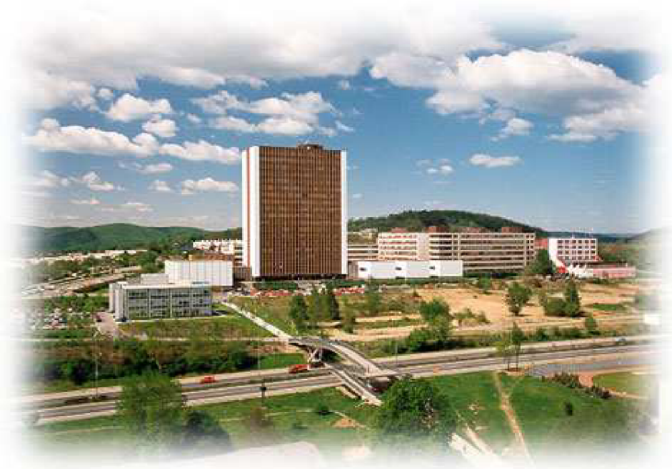
Obr. 1 Budova A1 v areálu FSI VUT v Brně [3]
