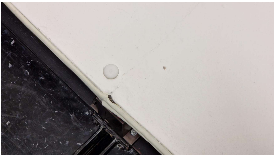
Obr. 24: Fotodokumentace – detail dna – záslepka ve dně a teplotní čidlo
