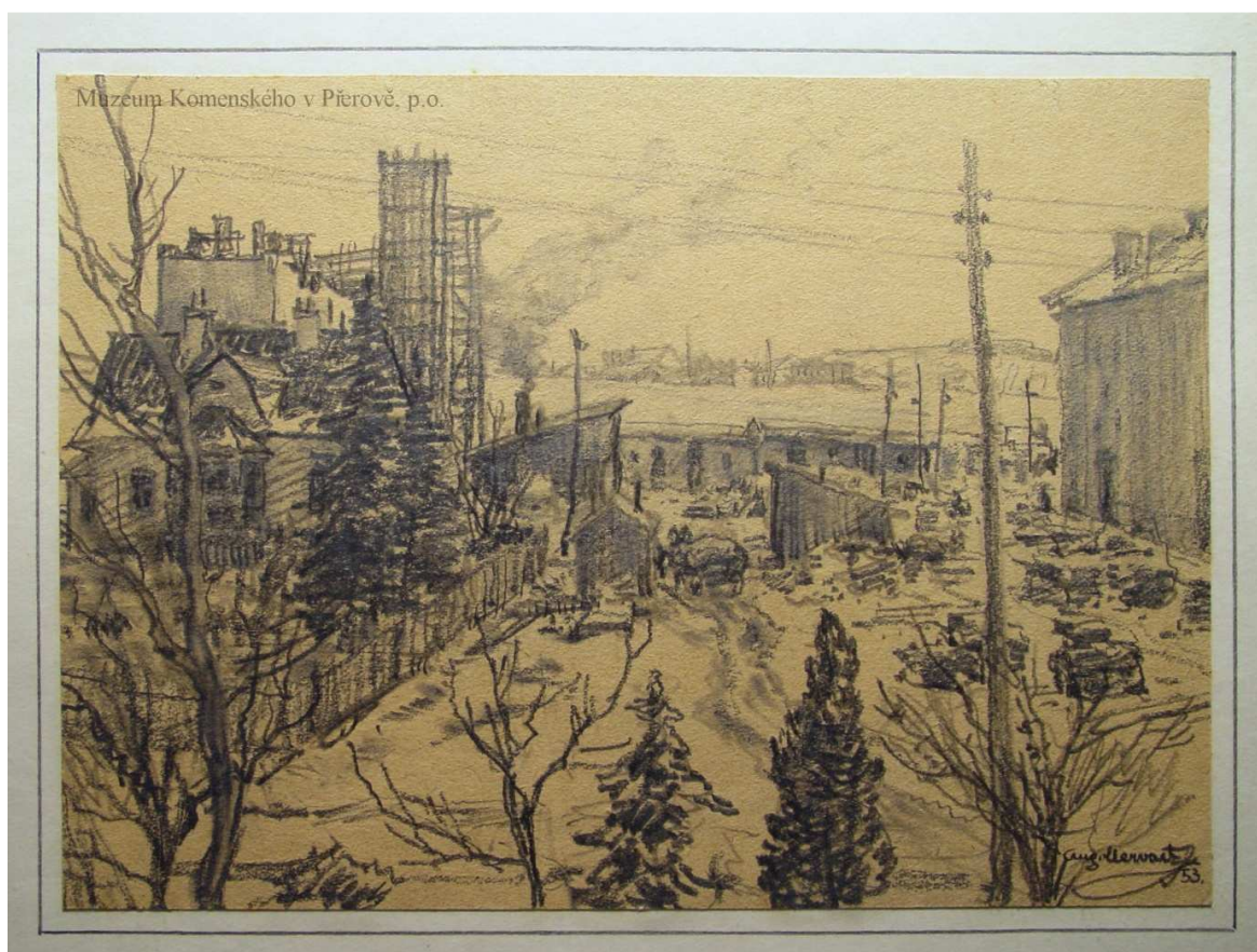
Stavba obytných domů, 1953 [105]
