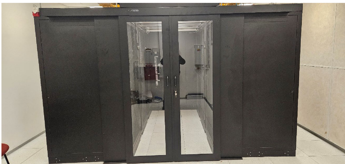
Obr 21 Fotka serveru v High-tech technologickém-výukovém pavilonu Fakulty lesnické a dřevařské na České zemědělské univerzitě
