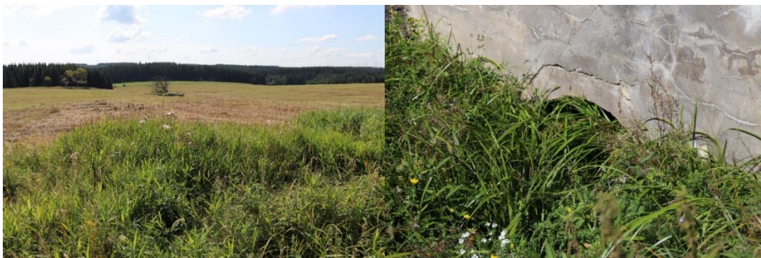
Obr. 22–23. Pohled na trasu pravostranného přítoku č. 1 v úseku P1-2 (vlevo) a detail propustku (vpravo)
