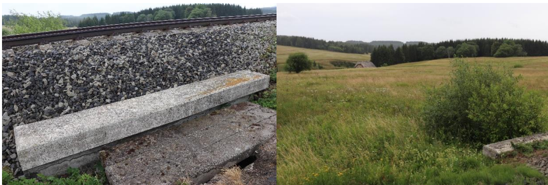
Obr. 28–29. Propustek pravostranného přítoku č. 2 v úseku P2 (vlevo) a okolní niva (vpravo)
