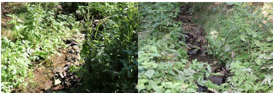
Obr. 40–41. Koryto levostranného přítoku č. 6 v úseku P6 (vlevo) a totéž koryto před vtokem do Novoveského potoka (vpravo)
