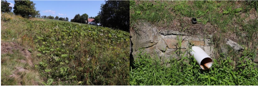
Obr. 32–33. Prameniště levostranného přítoku č. 4 v úseku P4 (vlevo) a zaústění jeho vod do koryta Novoveského potoka (vpravo)
