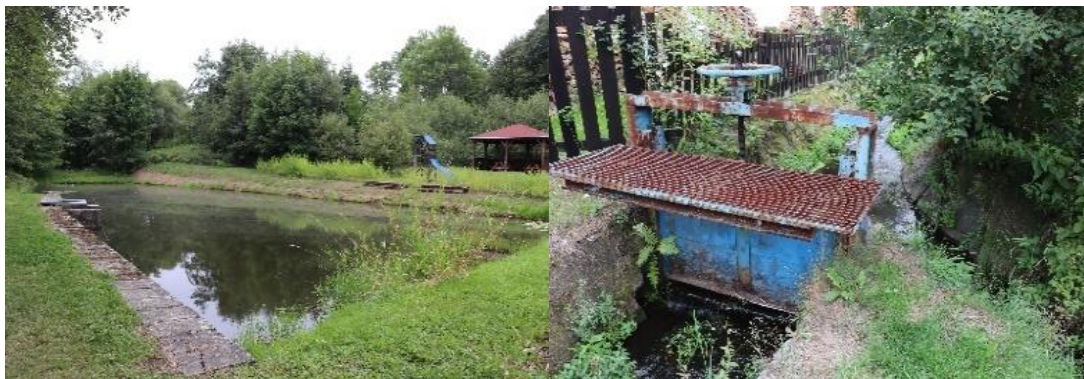
Obr. 2a. Vodní nádrž v obci Nová Ves (vlevo). Obr. 2b. Stavidlo nádrže (vpravo)
