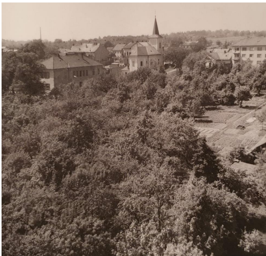
Obr. 9: Fotografie zachycující pohled na Olomouci – Novou Ulici před demolicí původní zástavby, 1969, autor originálu Leopold Plavec. NPÚ ÚOP Olomouc.
