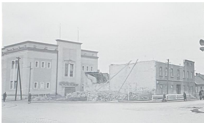
Obr. 74: Fotografie zachycující demolice domů v ulici Lipenská u divadla v Olomouci – Hodolanech, 1956, autor negativu J. Juryšek. VMO.
