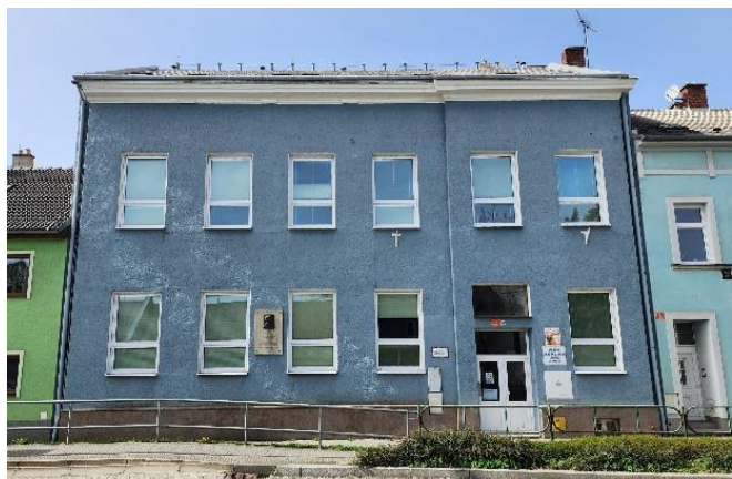
Obr. 89: Olomouc – Pavlovičky, Pavlovická č. p. 16, budova střední odborné školy služeb.
