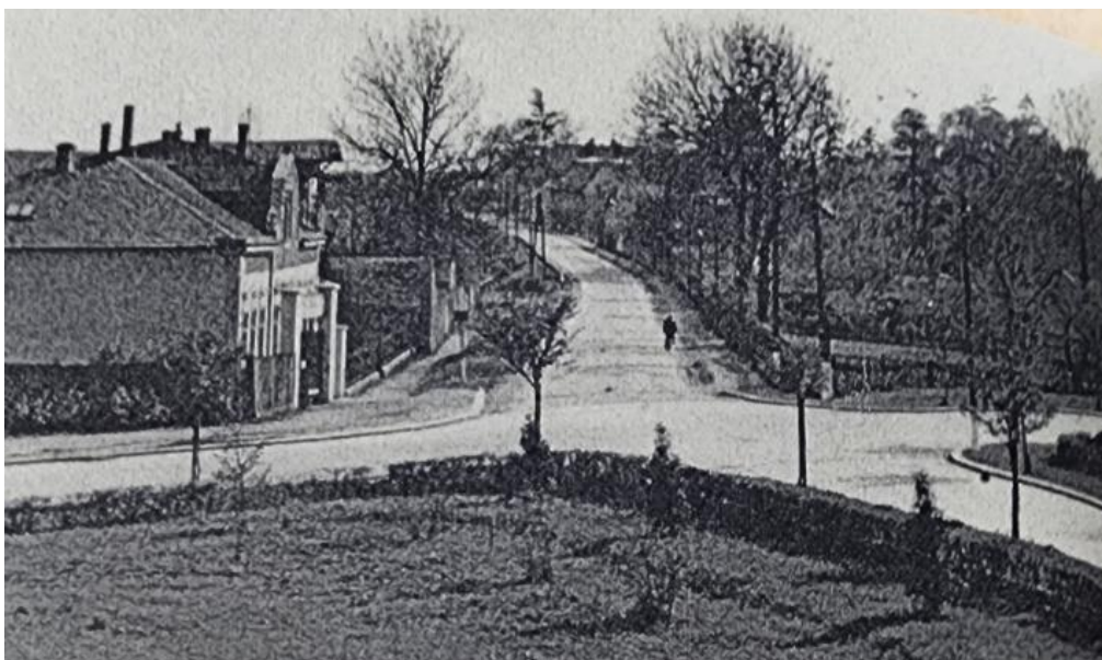
Obr. 28: Olomouc – Nová Ulice, zaniklé Ječmínkovo náměstí v roce 1944. Převzato z: Vilém Švec, Olomouc – Povel. Plošný průzkum, zhodnocení a dokumentace architektonického kulturního dědictví 19. a 20. století , Praha 2011, s. 28.
