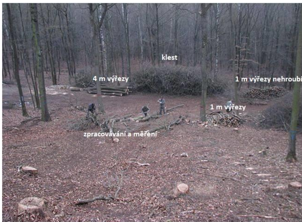
Obrázek 7: Dokumentace prací probíhajících na ploše
