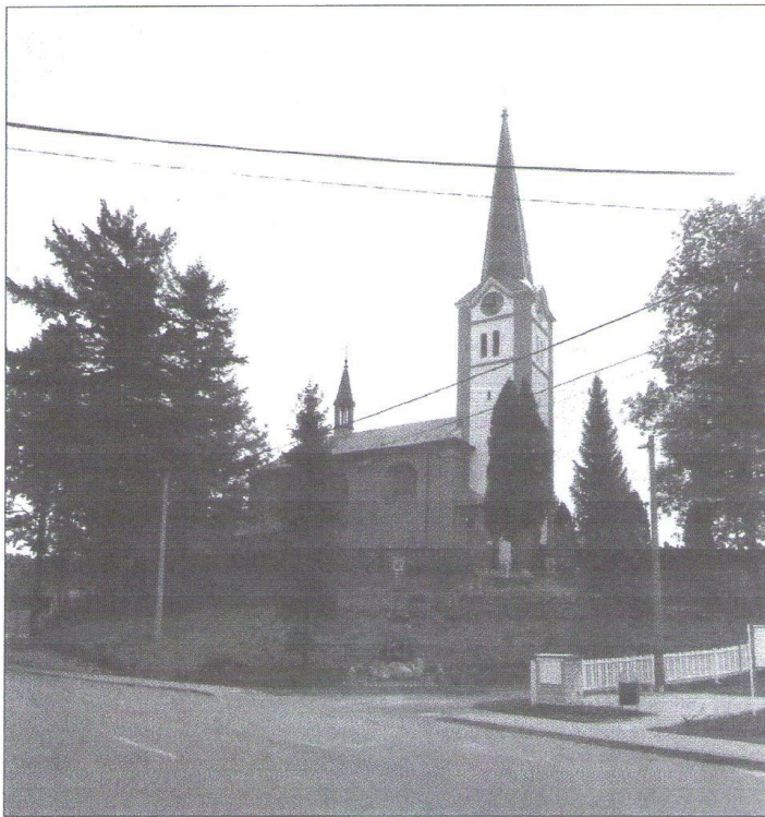
Kostel sv. Mikuláše v Hladkých Životicích má opravenou věž.
