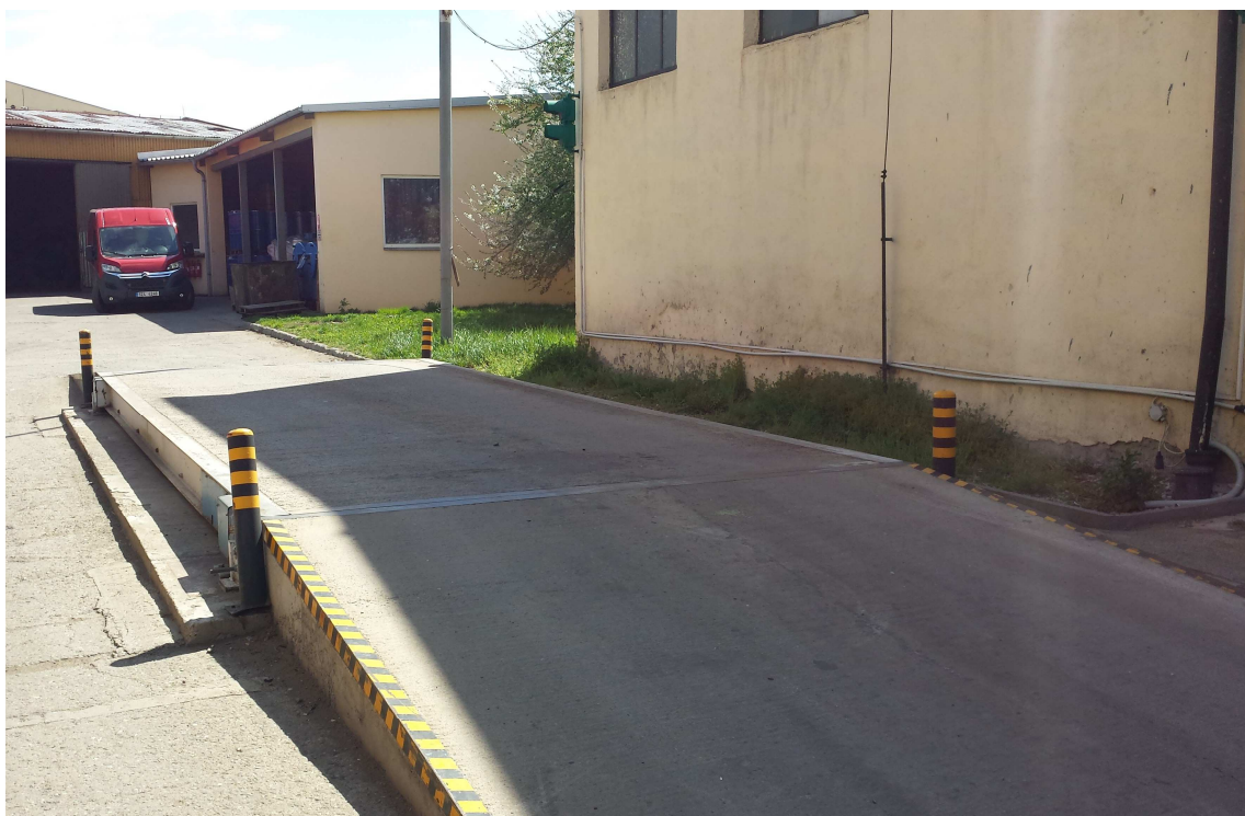
Obr. č. 13: Mostní váha
