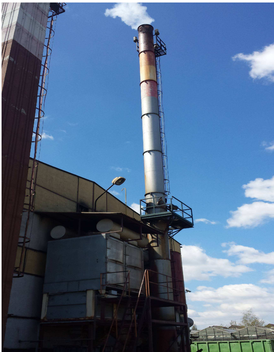
Obr. č. 8: Část spalovny s komínem
