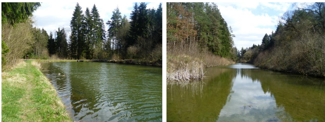
Obr. 37 Nehodnocený úsek SVI002 – Odkalovací nádrž (foto: autor)
