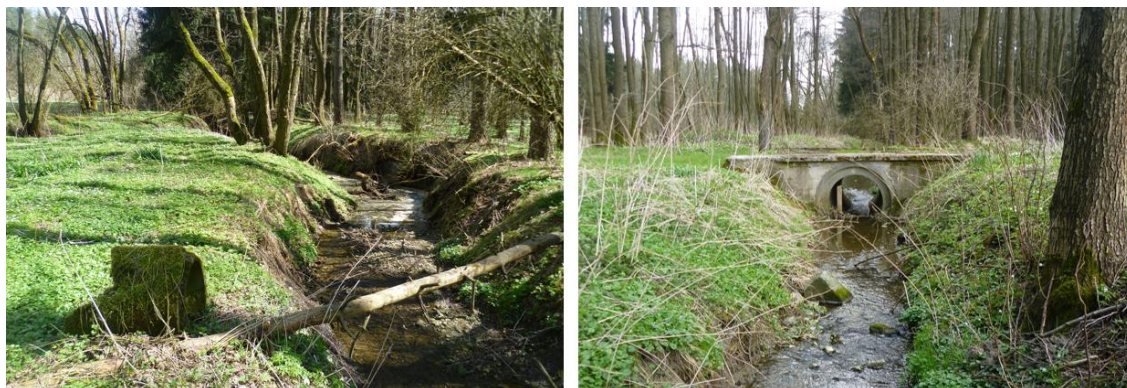
Obr. 40 Úsek JAV001, lesní trať (foto: autor)
