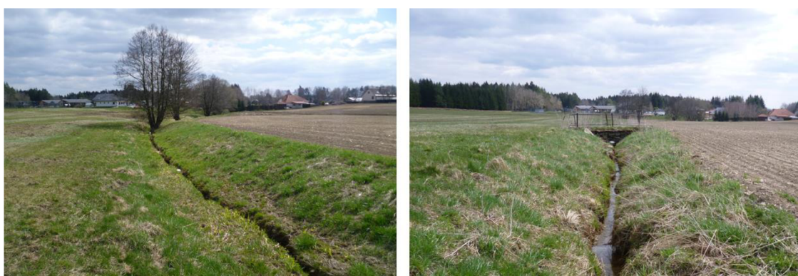
Obr. 44 Úsek JAV003, meliorační hlavník – dolní část (foto: autor)
