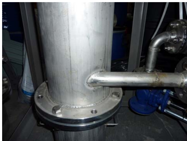
Obr 5.4 Tangenciální vstup do filtrační komory
