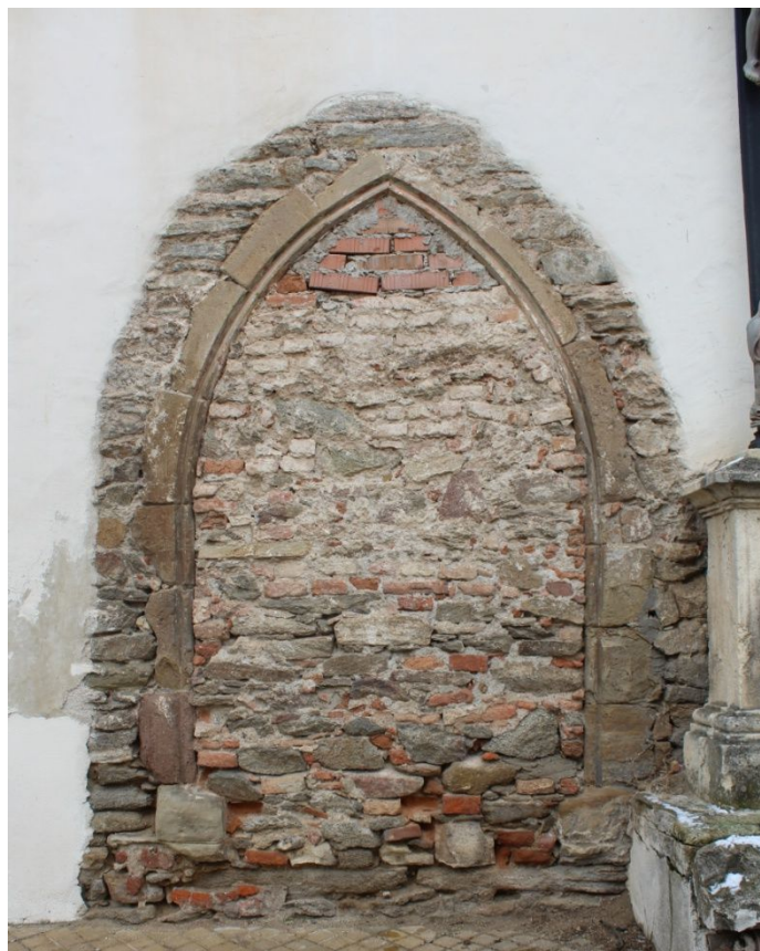
94. Znojmo, kostel sv. Michala, hrotitý portál zachovaný ve zdivu jižní stěny kostela
