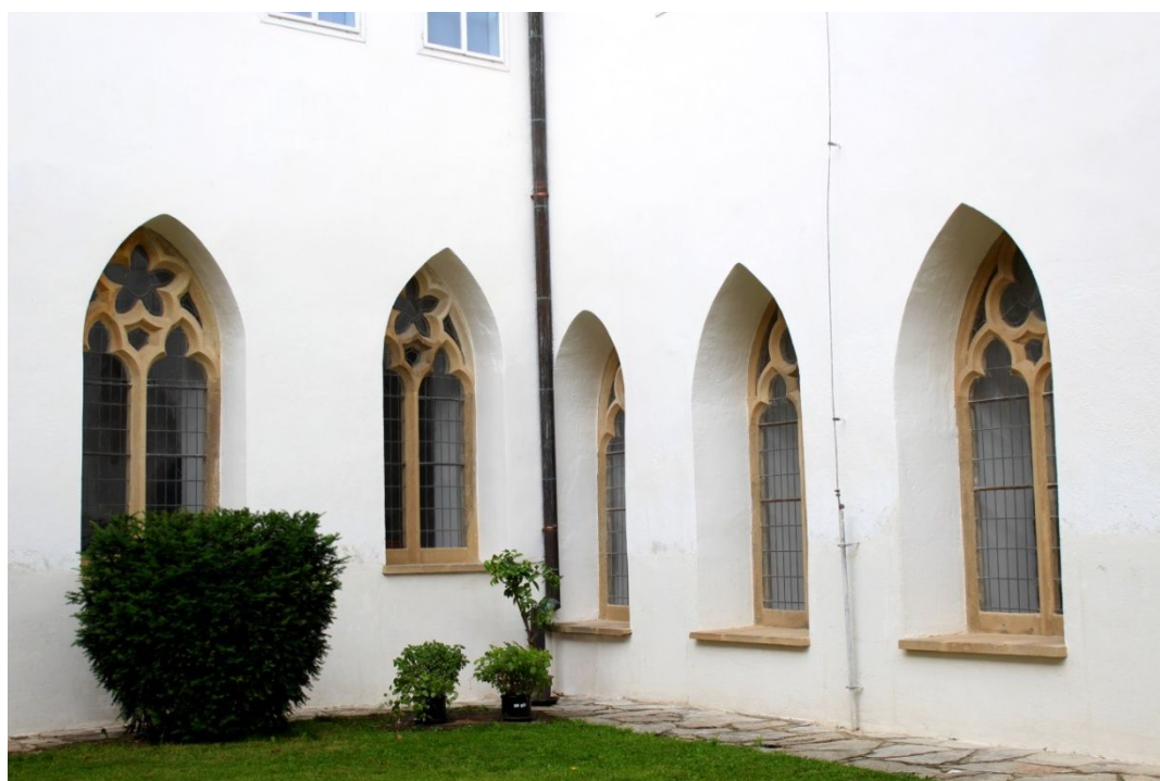
20. Znojmo, minoritský klášter, nároží severního a východního křídla ambitu s hrotitými okny vyplněnými kružbou, pohled z rajského dvora
