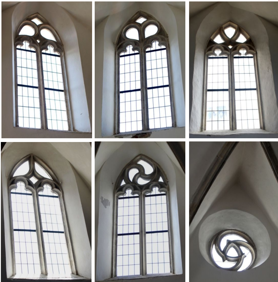
108. Znojmo, kaple sv. Anny, kružbové vzorce hrotitých oken a rozety
