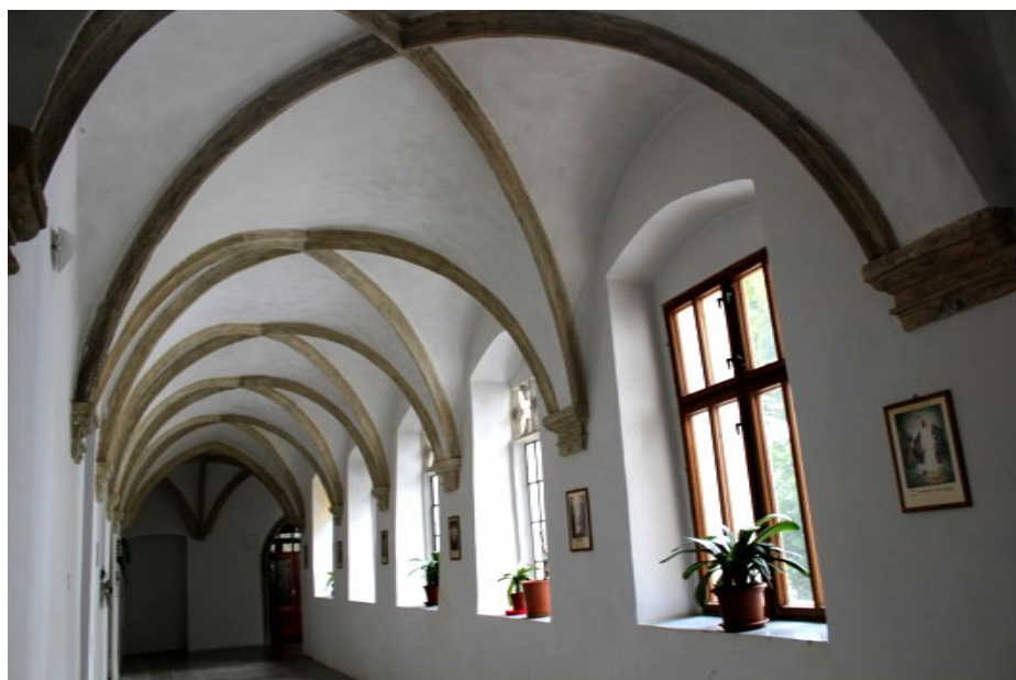
71. Znojmo, dominikánský klášter, východní křídlo ambitu s křížovou klenbou
