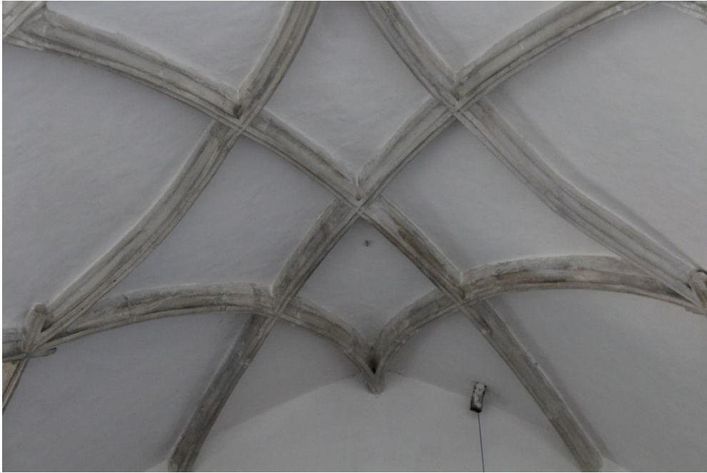
107. Znojmo, kaple sv. Anny, detail přetínajících se žebíř klenby
