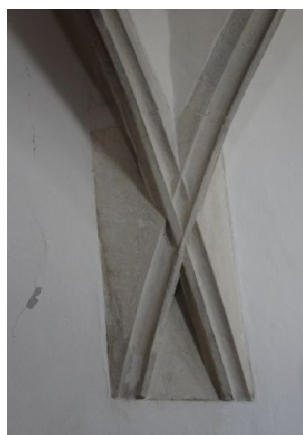
105. Znojmo, kaple sv. Anny, výběh klenebních žebér ze stěny
