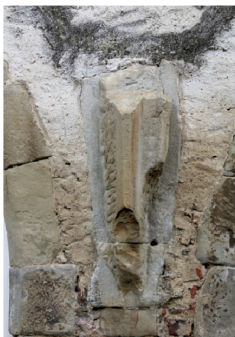
28. Znojmo, sdružený klášter minoritů a klarisek s kostelem Nanebevzetí Panny Marie, fragmenty jehlancových konzol klenby boční lodi minoritského kostela
