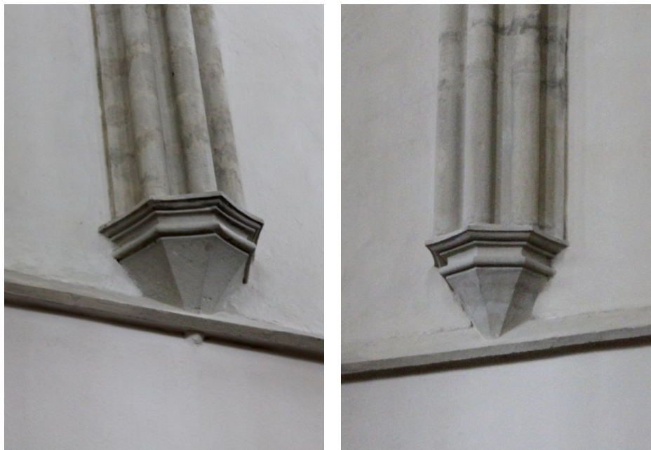
53. Znojmo, kostel sv. Mikuláše, trojsvazkové přípory s jehlancovými konzolami v obvodovém zdivu trojlodí, protínající podokenní římsu
