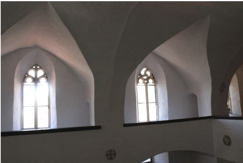
110. Znojmo, kaple sv. Martina, vnitřní ochoz mezi vtaženými pilíři a hrotitá okna s kružbou
