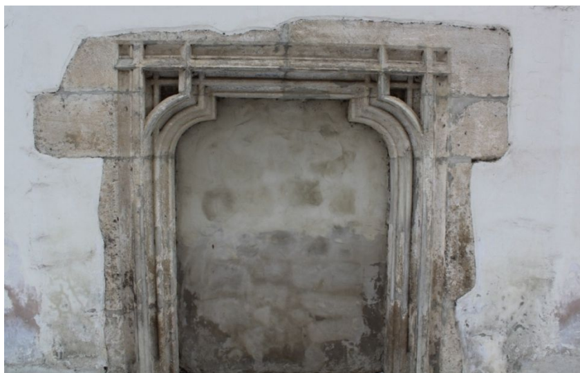
89. Znojmo, kostel sv. Michala, zarděný severní gotický sedlový portál
