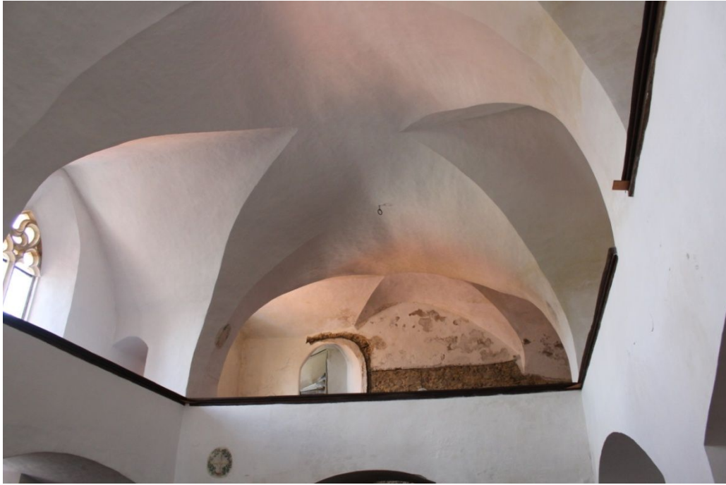
109. Znojmo, kaple sv. Martina, valená klenba s lunetovými výsečemi
