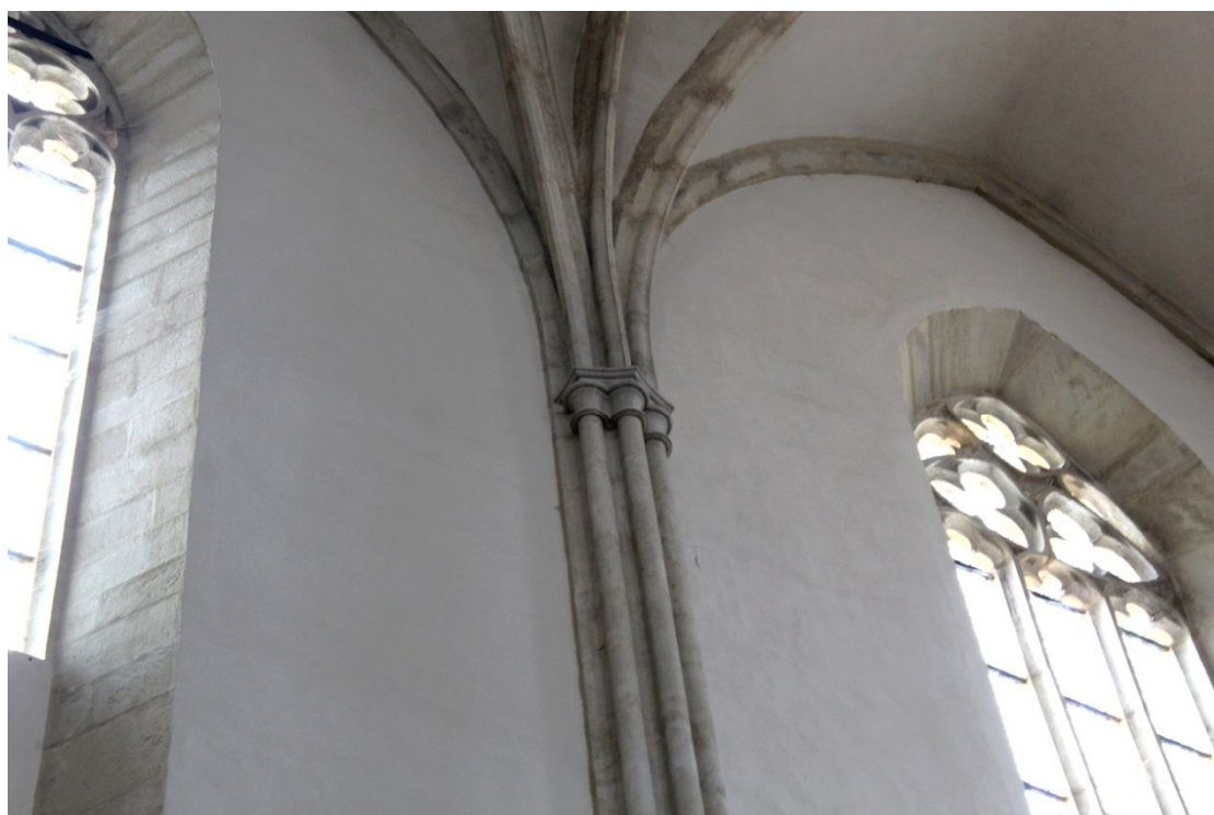
54. Znojmo, kostel sv. Mikuláše, prstencové hlavice trojsvazkových přípor v obvodovém zdivu trojlodí
