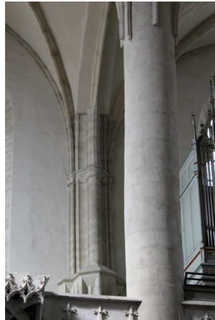
47. Znojmo, kostel sv. Mikuláše, západní pilíře nad kruchtou, profilované již oblouny
