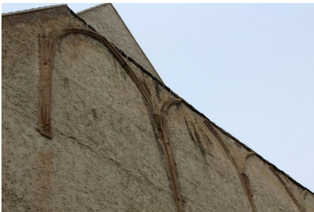
27. Znojmo, sdružený klášter minoritů a klarisek s kostelem Nanebevzetí Panny Marie, otisky klenby empory klarisek v patře nad boční lodí minoritského kostela
