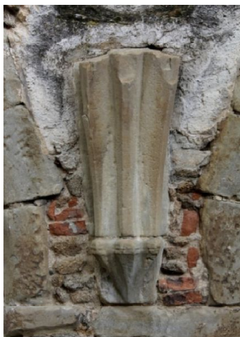
28. Znojmo, sdružený klášter minoritů a klarisek s kostelem Nanebevzetí Panny Marie, fragmenty jehlancových konzol klenby boční lodi minoritského kostela
