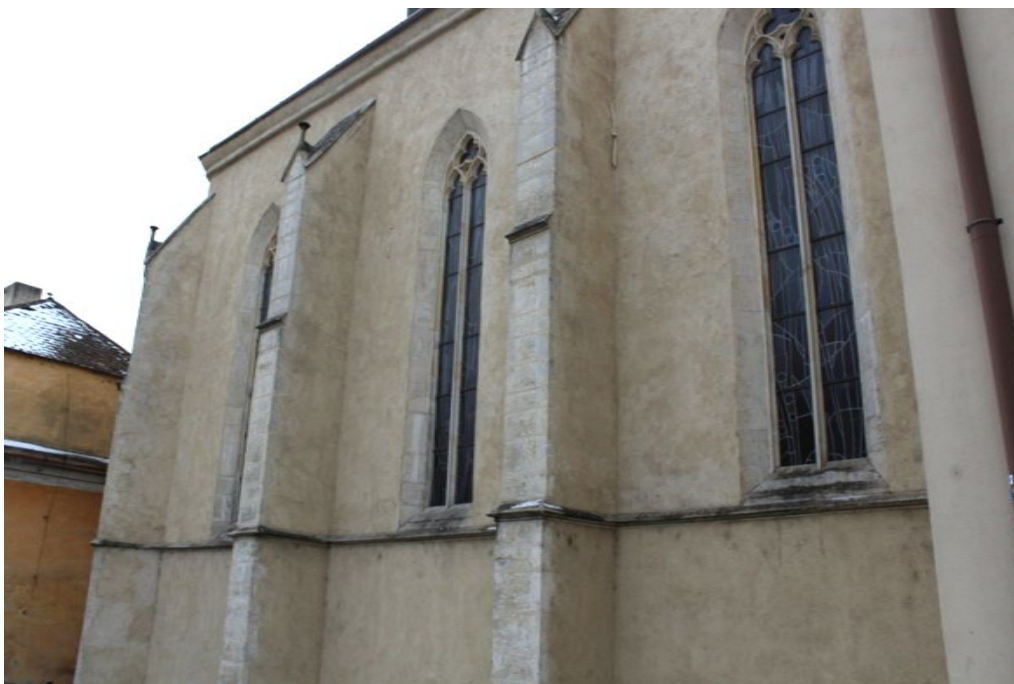
82. Znojmo, kostel sv. Alžběty, východní strana presbytáře s vnějšími opěráky
