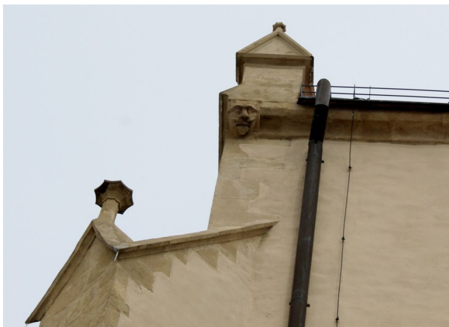
44. Znojmo, kostel sv. Mikuláše, detail výzdoby opěráku s gotickou kytkou a maskaron v jihozápadním nároží chrámu
