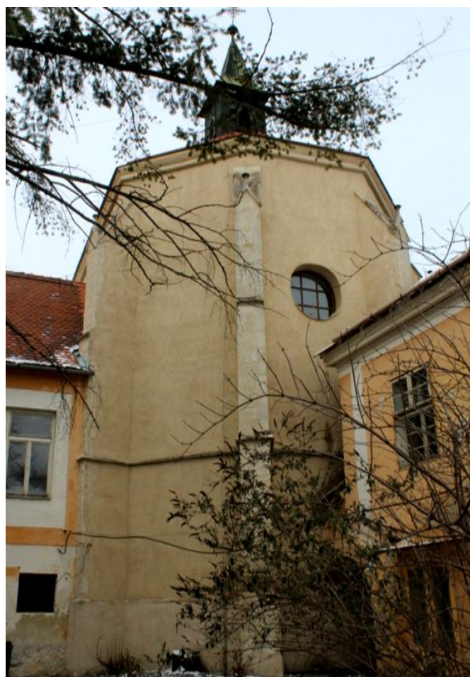
83. Znojmo, kostel sv. Alžběty, jižní strana presbytáře
