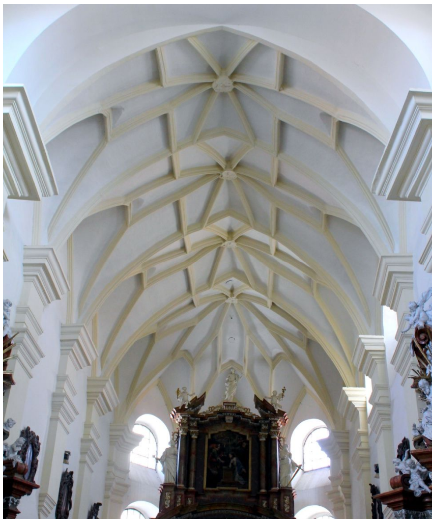
95. Znojmo, kostel sv. Michala, valená klenba presbytáře tvořená sítí prostupujících se hvězd
