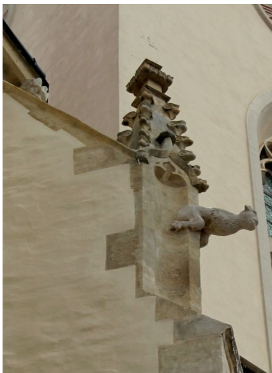
43. Znojmo, kostel sv. Mikuláše, detail výzdoby jižního opěráku presbytáře s fialou a chrličem
