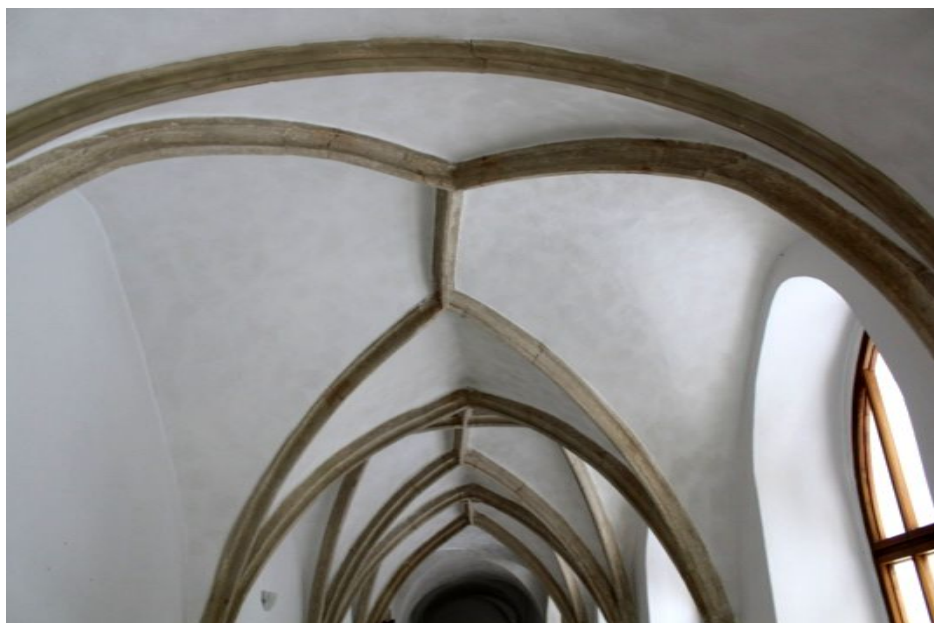
74. Znojmo, dominikánský klášter, tři pole hvězdicové klenby v severním křídle ambitu
