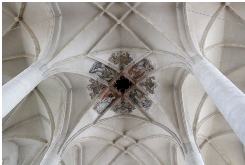
60. Znojmo, kostel sv. Mikuláše, síťová klenba hlavní lodi s otvorem Ducha svatého
