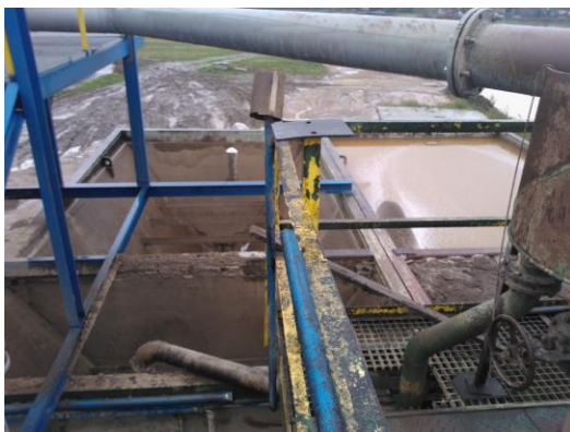
Obr. 55 – Lamelový usazovák (Litovel) [47] Obr. 56 – Schéma lamelového usazováký [50]
