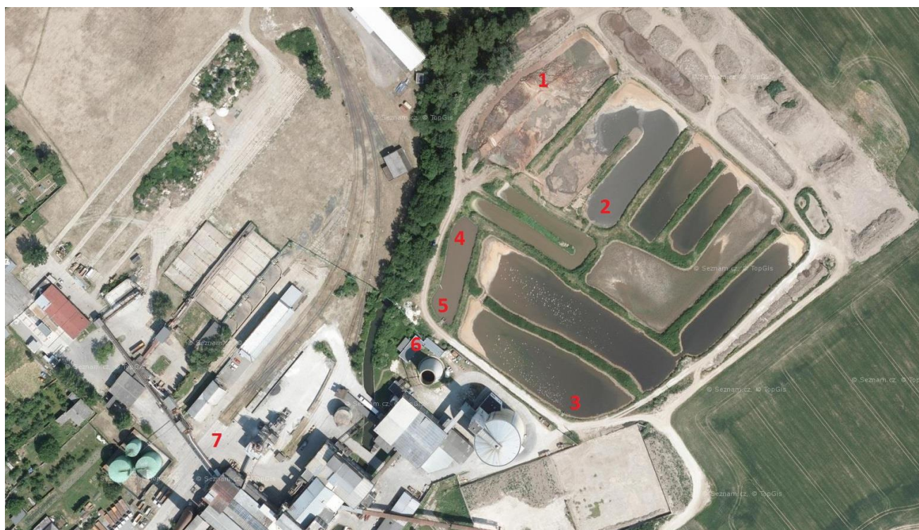
Obr. 79 – Hospodářství odpadních vod v cukrovaru Prosenice. 1 – nátok odpadní vody plavící a prací, 2 – systém kalových polí, 3 – přepad odsazené plavící a prací vody, 4 – chladičí rybník barometrických vod, 5 – přepad ochlazené barometrické vody 6 – čerpací stanice odsazené vody do okruhu plavících a pracích vod a ochlazené vody do technologie, 7 – výrobní budovy cukrovaru [64]
