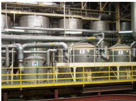
Obr. 32 – Ohřivače lehké šťávy (Dobrovice) [29]
