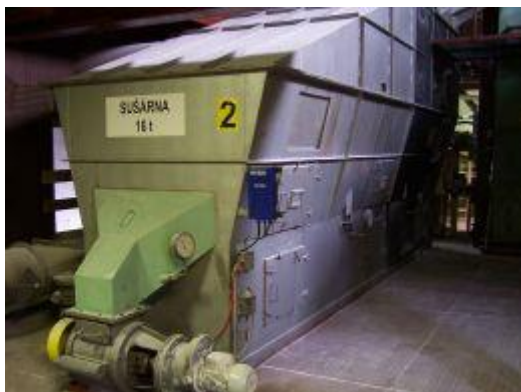
Obr. 40 – Sušárna cukru (Dobrovice) [29]
