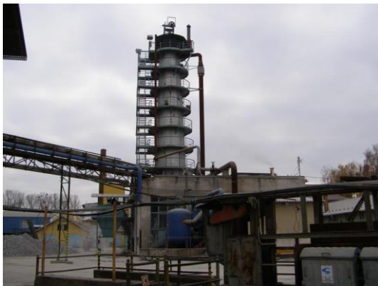
Obr. 30 – Khernova vápenka s hašenkou. V popředí je vidět modrá nádoba lavéru (Vrbátky) [30]
