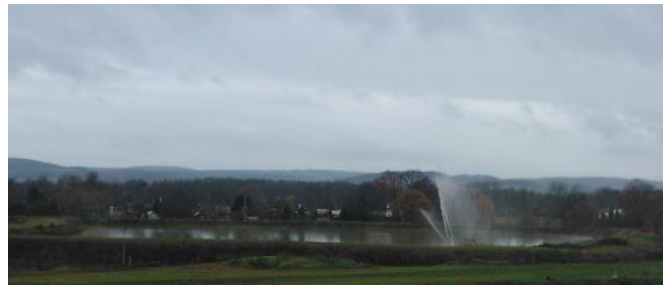
Obr. 72 – Chladicí rybník s rozstřikem vody tryskami (Litovel) [47]
