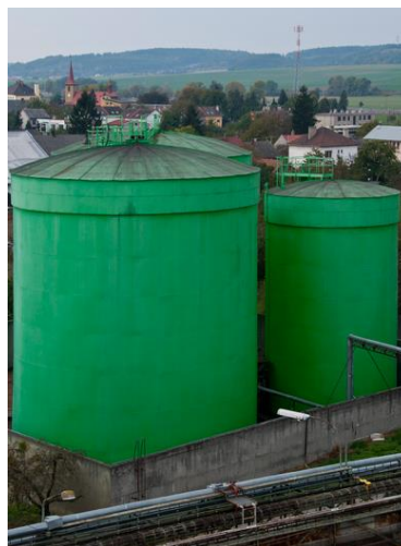
Obr. 39 – Nádrže na melasu (Prosenice) [27]
