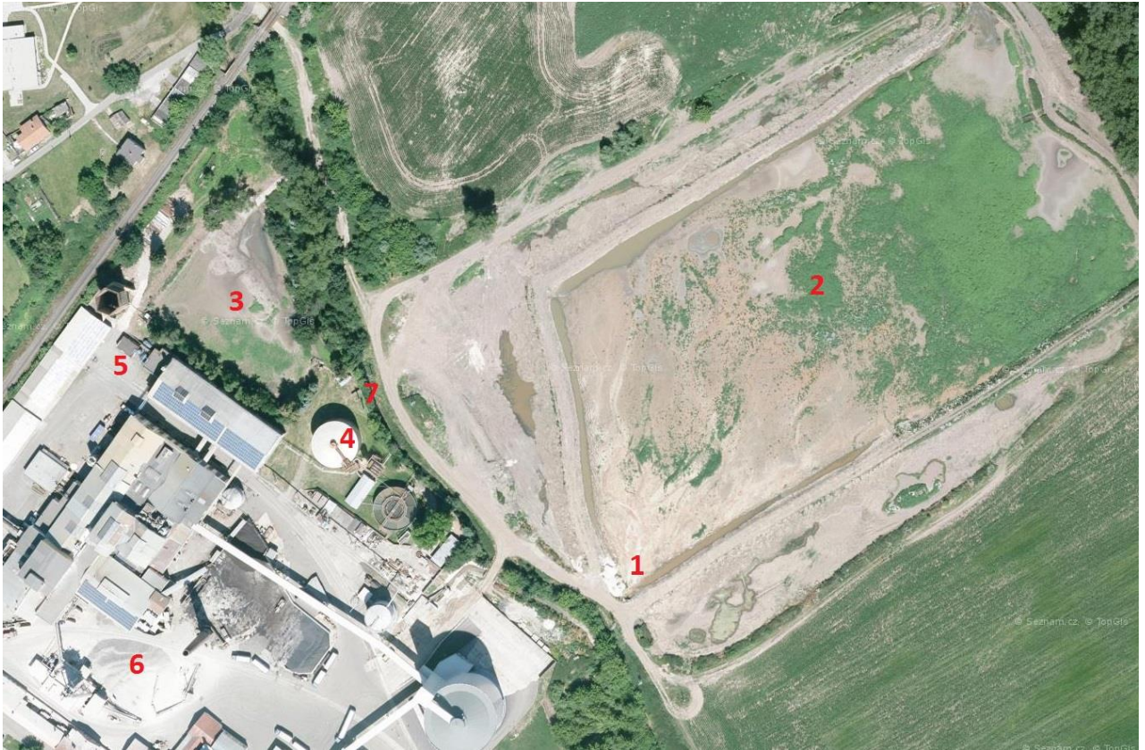
Obr. 82 – Hospodářství odpadních vod v cukrovaru Vrbátky. 1 – vpust' znečištěné odpadní vody plavicí a prací, 2 – kalový rybník, 3 – akumulční rybník, 4 – průmyslová ČOV, 5 – čerpací stanice okruhu předčištěných plavicích a pracích vod, 6 – výrobní budovy cukrovaru, 7 – umístění šoupat pro přívod vody do kalového a akumulčního rybníku z Vrbáteckého náhonu [67]
