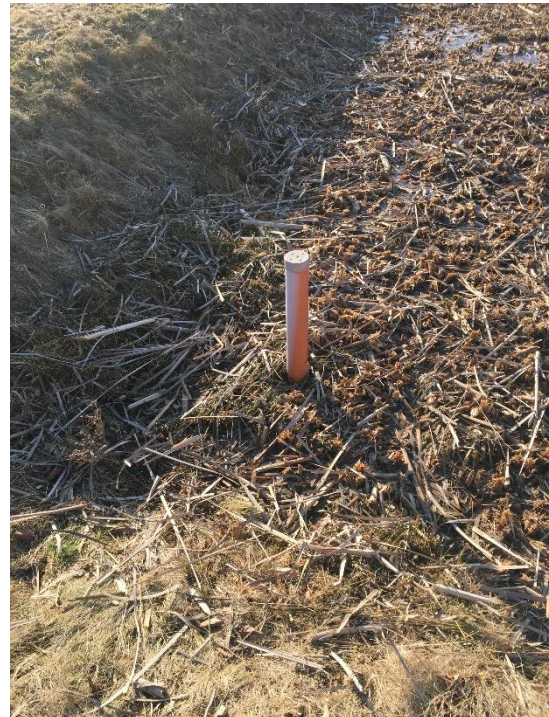
Obr. 15 a 16: Odtokové šachtice v kořenových polích – místa odběru vzorků vody č. 3 na odtoku, KČOV Sedlečko u Soběslavě (zdroj: Vlastní)
