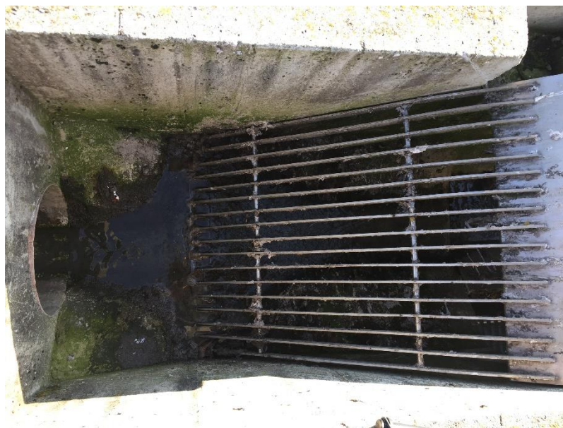
Obr. 8: Manuálně stírané česle zpravidla 1 x týdně, KČOV Sedlečko u Soběslavě (Zdroj: vlastní)
