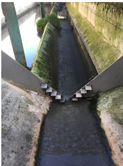
Obr. 9: Thomsonův měrný přeliv na kořenové čistírně v Sedlečku u Soběslavě (Zdroj: vlastní)
