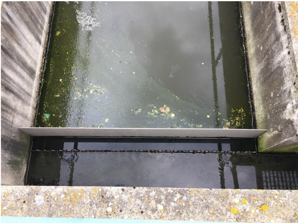
Obr. 14: Místo odběru vzorků vody č. 2: usazovací nádrž, KČOV Sedlečko u Soběslavě (Zdroj: Vlastní)
