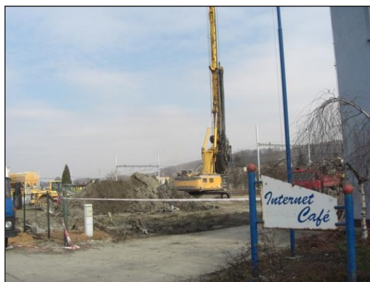
obr. 54 Zemní práce související s realizací mimoúrovňového přejezdu Via Lyžbice
