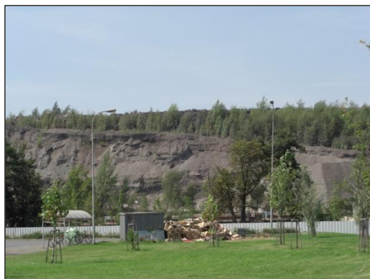
Obr. 23 Strže na východním svahu haly
