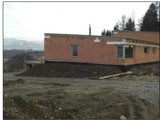
Obr. 36 Vyrovnávání terénu navážkami ve Vělopolí Foto: M. Bobková (3/2012)
