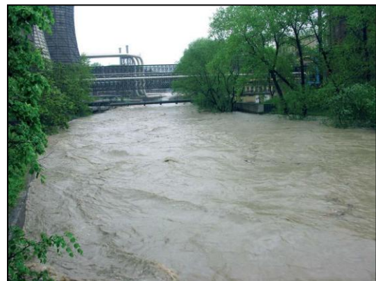
Obr. 20 Rozvodněná Olše u mostu u hlavní brány
