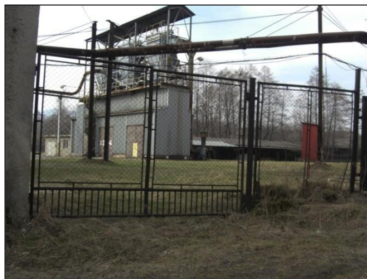
Obr. 46 Areál dřevomodelárny TŽ
