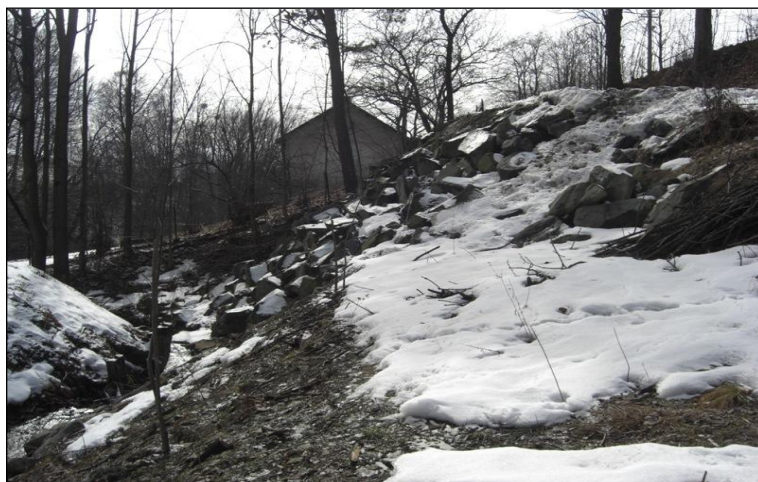
Obr. 59 Sanace svahu přitěžovací lavicí s hrubého lomového kamene ve Vendryni
