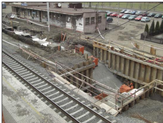
Obr. 51 Výstavba podchodu Třinec – Korská Foto: M. Bobková (3/2010)
