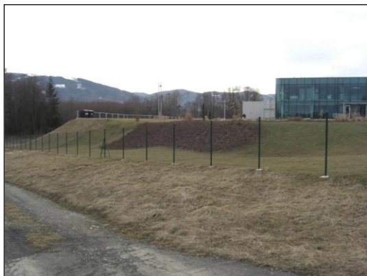
Obr. 49 Navážky v areálu průmyslové zóny Optimont 2000, s.r.o.
