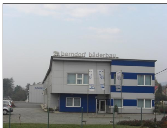
Obr. 48 Průmyslové zóna Berndorf Bäderbau, a.s. v Bystřici
