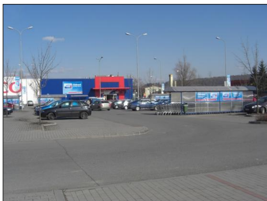
Obr. 37 Obchodní zóna na ulici Frýdecké při povodních 2010 prostor zatopený
