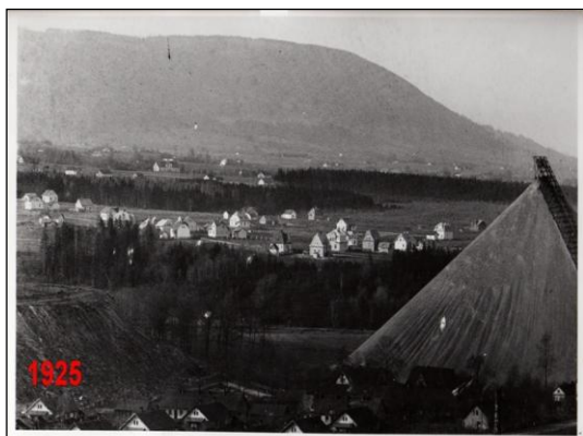
Obr. 25 Dobová fotografie kuželového úsypu, v dolní části jsou patrné četné erozní rýhy
