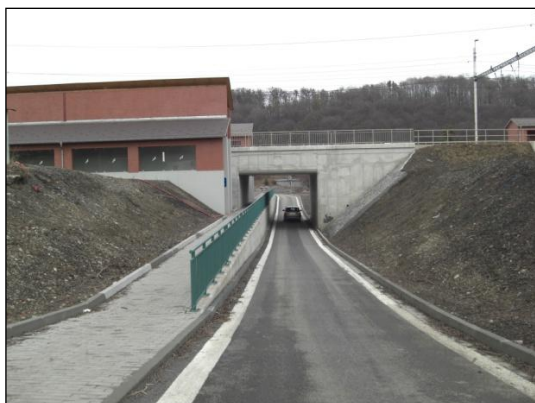
Obr.53 Mimoúrovňový přejezd a násyp v lokalitě Ropice
