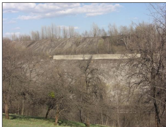
Obr. 24 Zabezpečení západního svahu haldy
