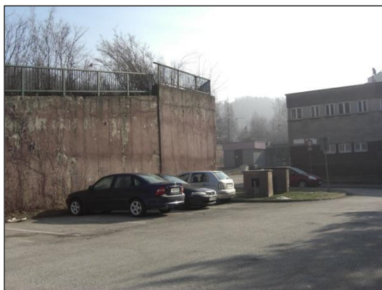
Obr. 41 Opěrná zeď v lokalitě sídliště Sosna
