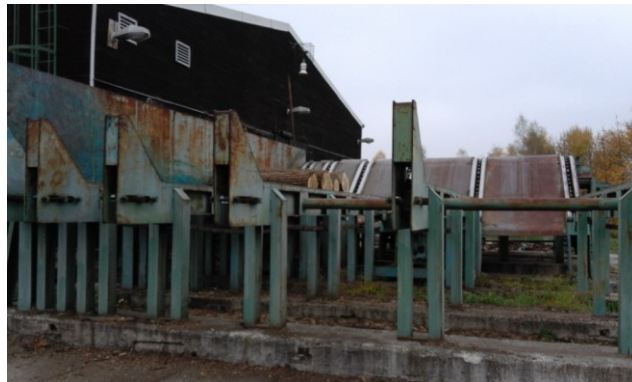
Obr. 6 Pilnice I. – elevátor, dávkování výřezů
