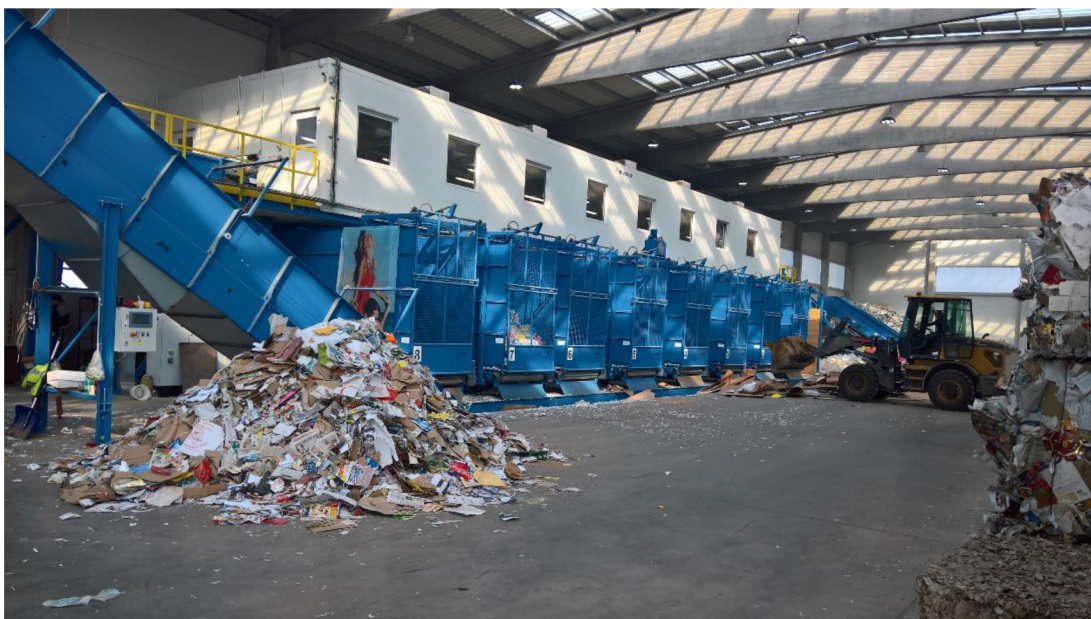
Obrázek 7: Příjmová hala dotříd'ovací linky – pohled na manipulační techniku
