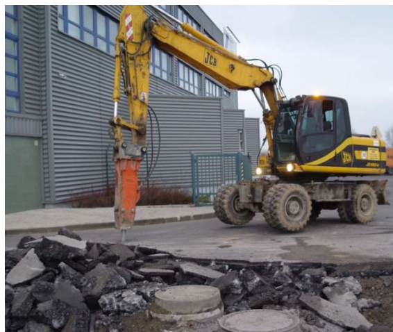
Obr. 2: Bourání vozovky [5]
