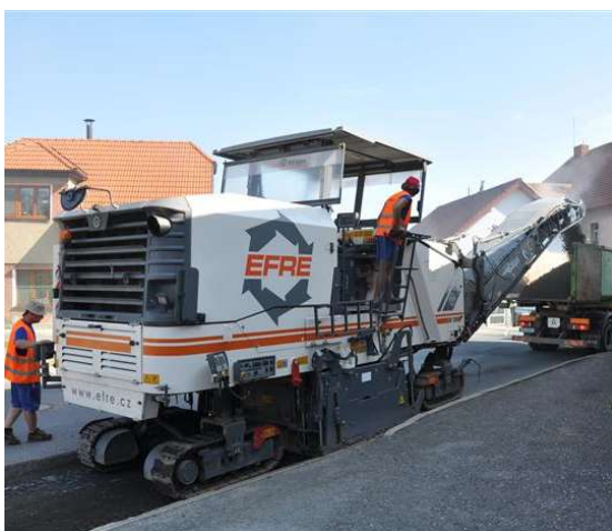
Obr. 1: Frézování vozovky [4]
