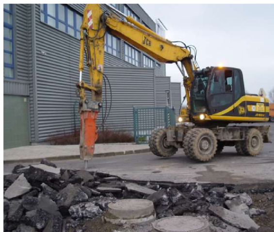
Obr. 2: Bourání vozovky [5]
