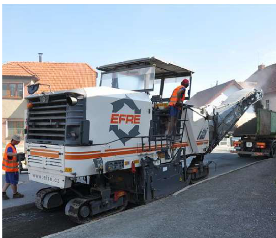
Obr. 1: Frézování vozovky [4]
