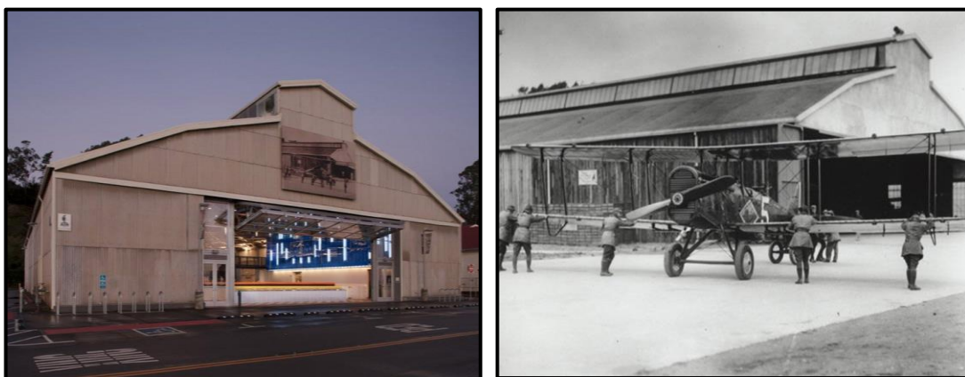
Obrázek č. 27: Pohled na budovy House of Air. Obrázek č. 28: Cedula s historickým snímkem.
