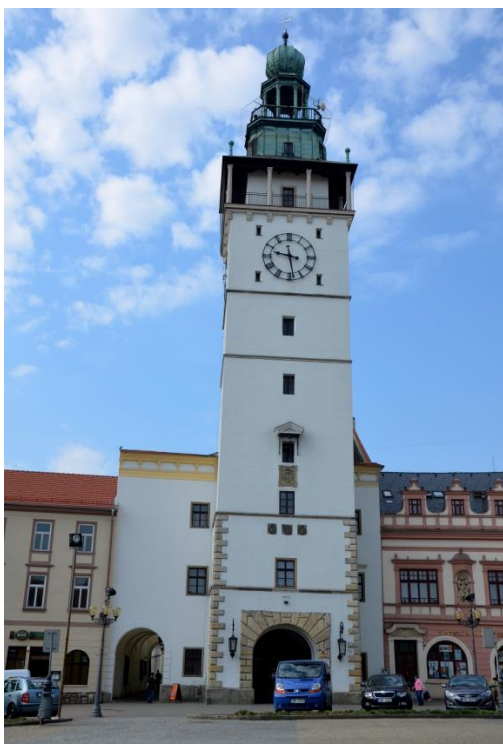
21. Průčelí hlavní radniční budovy a věže; v přízemí a prvním patře původní renesanční armování, v přízemí renesanční bosáž portálu
