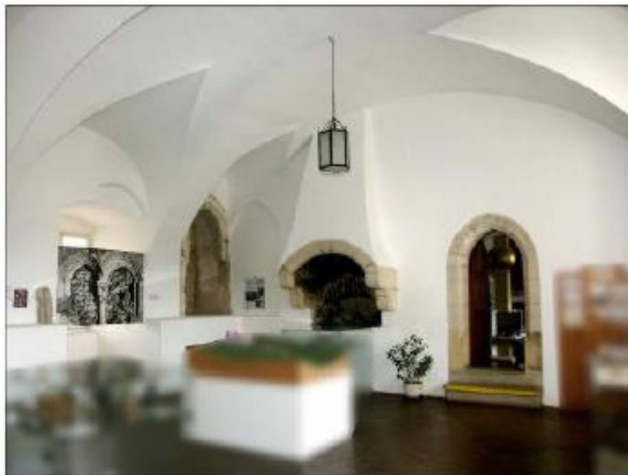
43. Jedna z přízemních místností severního křídla s dochovanými pozdně gotickými články a raně renesanční hřebínkovou klenbou
