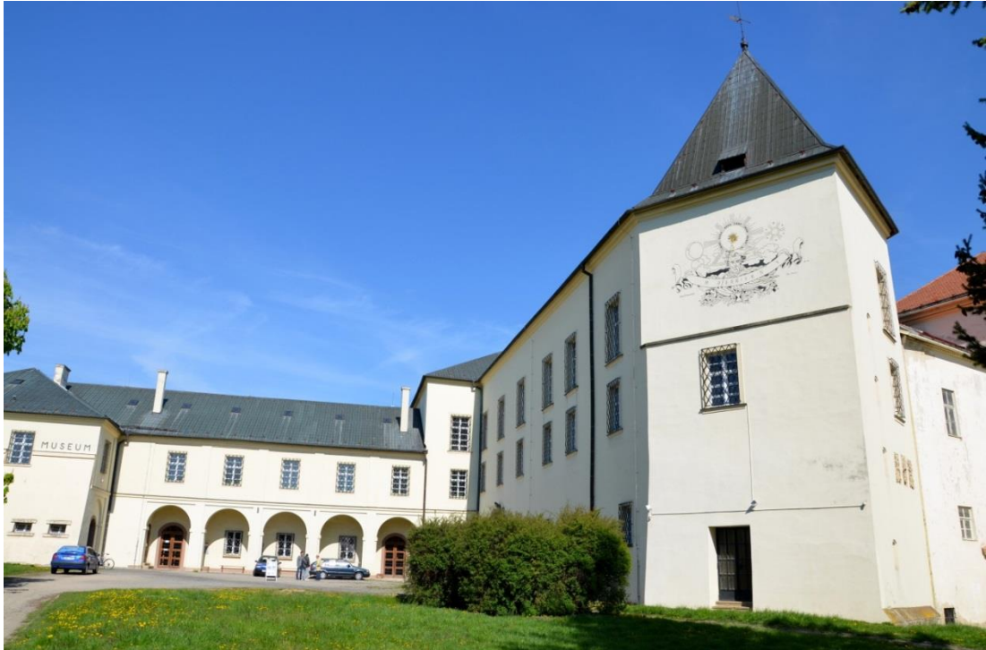
37. Starší část vyškovského zámku; v popředí severní křídlo s poslední dochovanou věží, v pozadí křídlo západní
