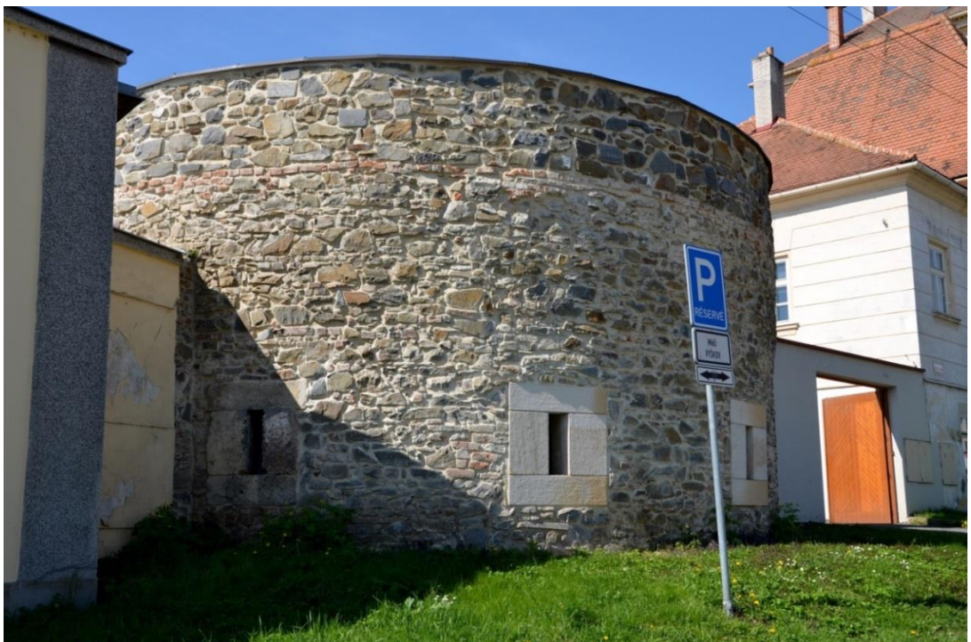
58. Renesanční bašta v nejvýchodnějším cípu zámeckého komplexu; úplně vlevo jediná autentická střílna
