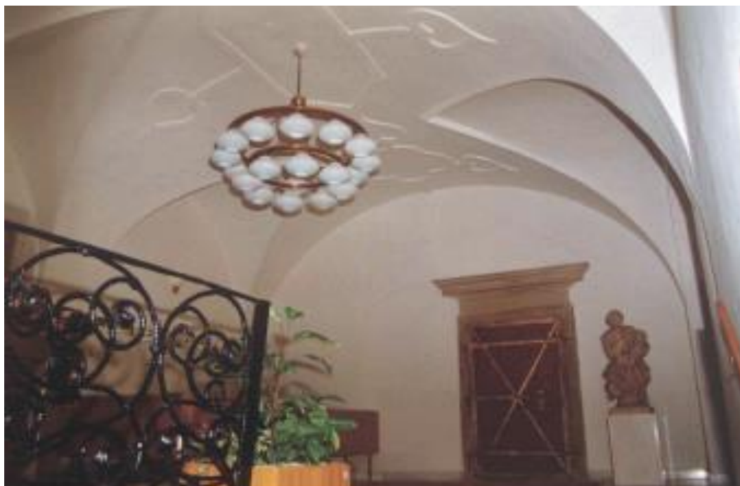
31. Předsíň 1. patra radniční budovy zaklenutá renesanční valenou eliptickou klenbou s hřebínkovými výsečemi ve tvaru lomeného oblouku a s dekorativní štukou z období pozdní renesance
