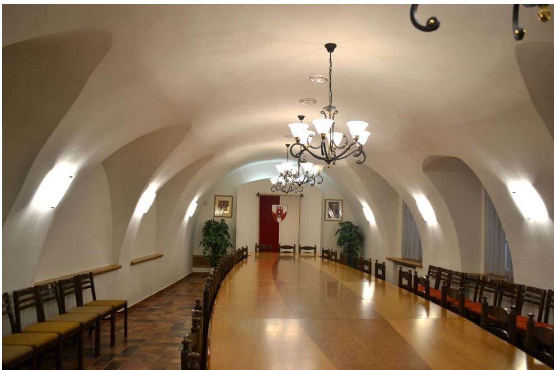
28. Interiér krátkého dvorního křídla; zasedací síň s gotickou valenou eliptickou klenbou se třemi páry trojbokých výsečí
