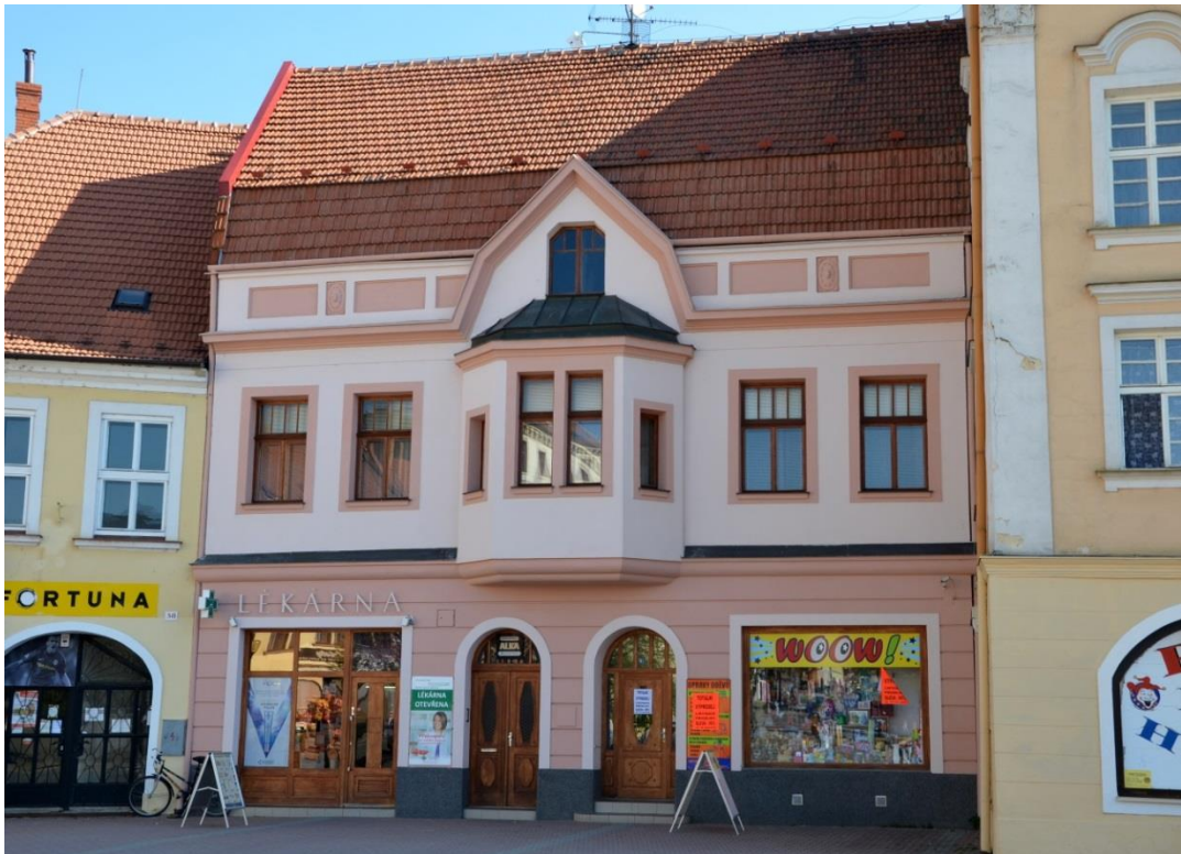
62. Průčelí měšťanského domu čp. 43
