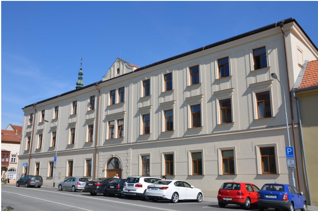
72. Průčelí měšťanského domu čp. 112
