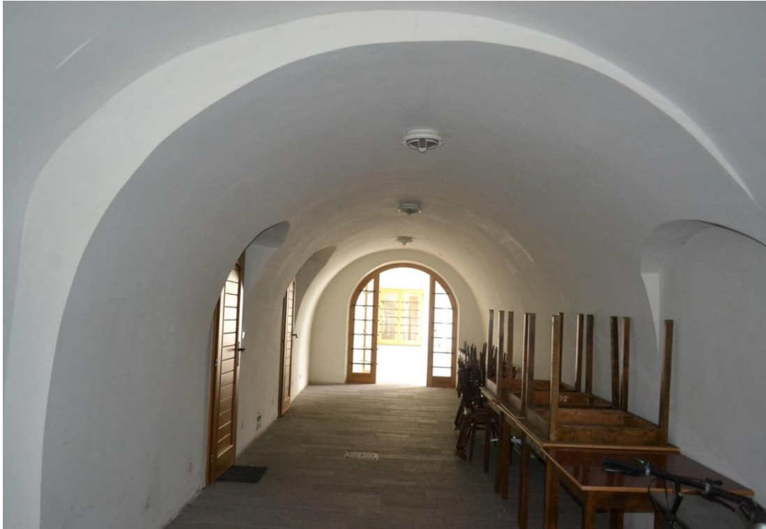
27. Zadní část přízemního průjezdu zaklenutá gotickou půlkruhovou valenou klenbou
