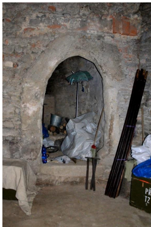
52. Místo původního vstupu do sklepení s mladší cihlovou výplní po odstraněném schodišti (vpravo) a pozdně gotický portál zazděného schodiště v nejuvýchodnější z místností
