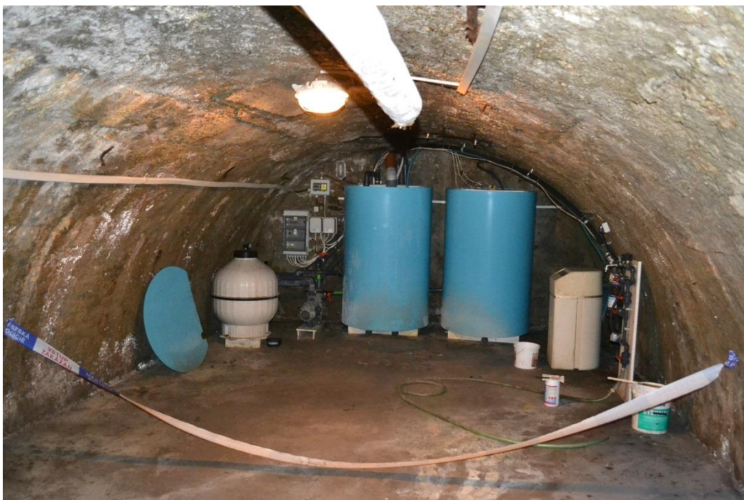
35. Jedna z tunelovitých gotických místností západního radničního sklepa s valenou eliptickou klenbou
