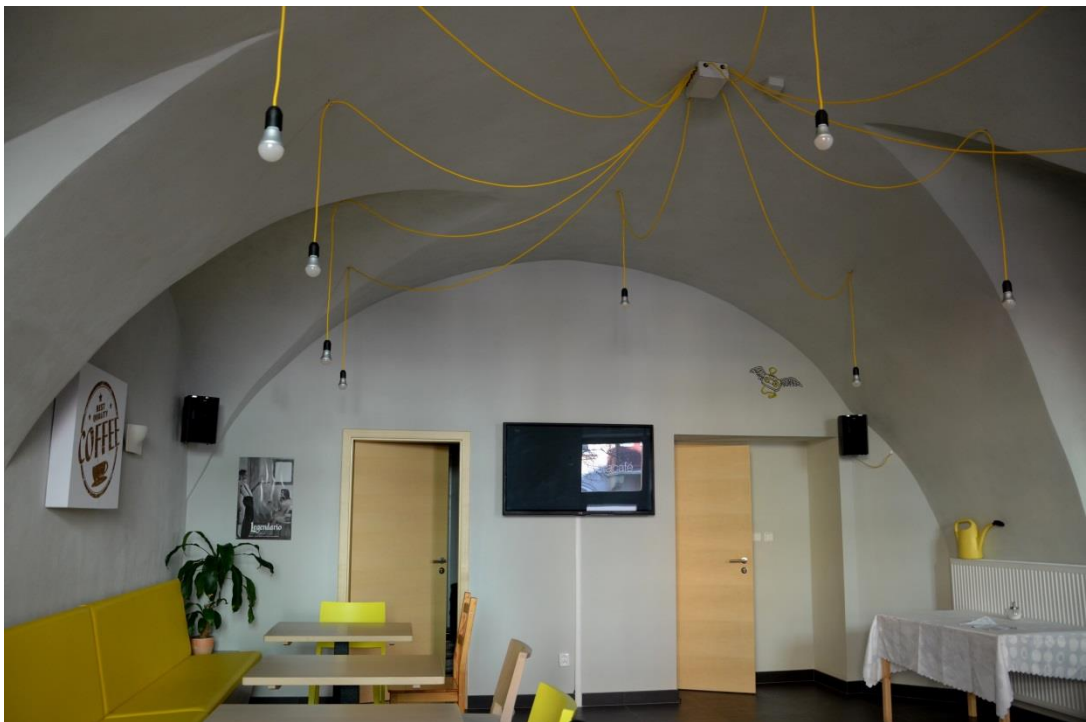
73. Renesanční lunetová klenba v interiéru měšťanského domu čp. 112
