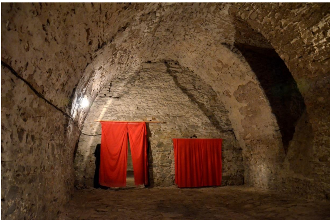
55. Nejzápadnější z pozdně gotických místností s lomenou klenbou ze dvou třetin původní (vpředu) a jednou třetinou sekundárně upravenou (vzadu)
