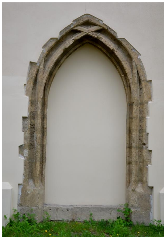
17. Severní portál farního kostela Nanebevzetí Panny Marie
