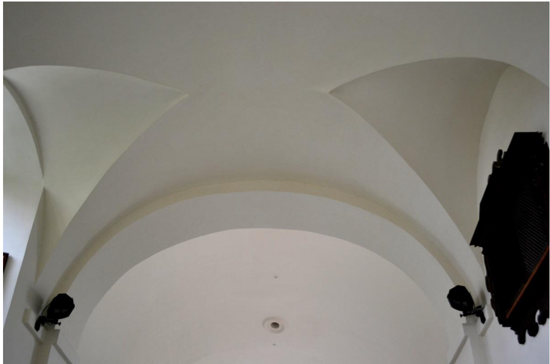
14. Renesanční půlkruhová valená klenba presbytáře hřbitovního kostela Panny Marie s trojúhelníkovými výsečemi
