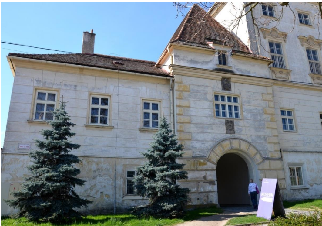
59. Vstupní brána do zámeckého areálu s částečně dochovanými renesančními portály a přilehlé stavení se sekundárně omítnutými renesančními obvodovými zdmi
