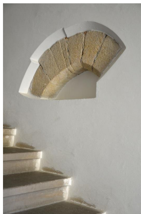
44. Pozdně gotické prvky v jedné z přízemních místností severního zámeckého křídla; lomený portál se zbytkem šnekovitého schodiště (vlevo) a odkrytá archyvola zazděného původního vchodu do místnosti (vpravo)
