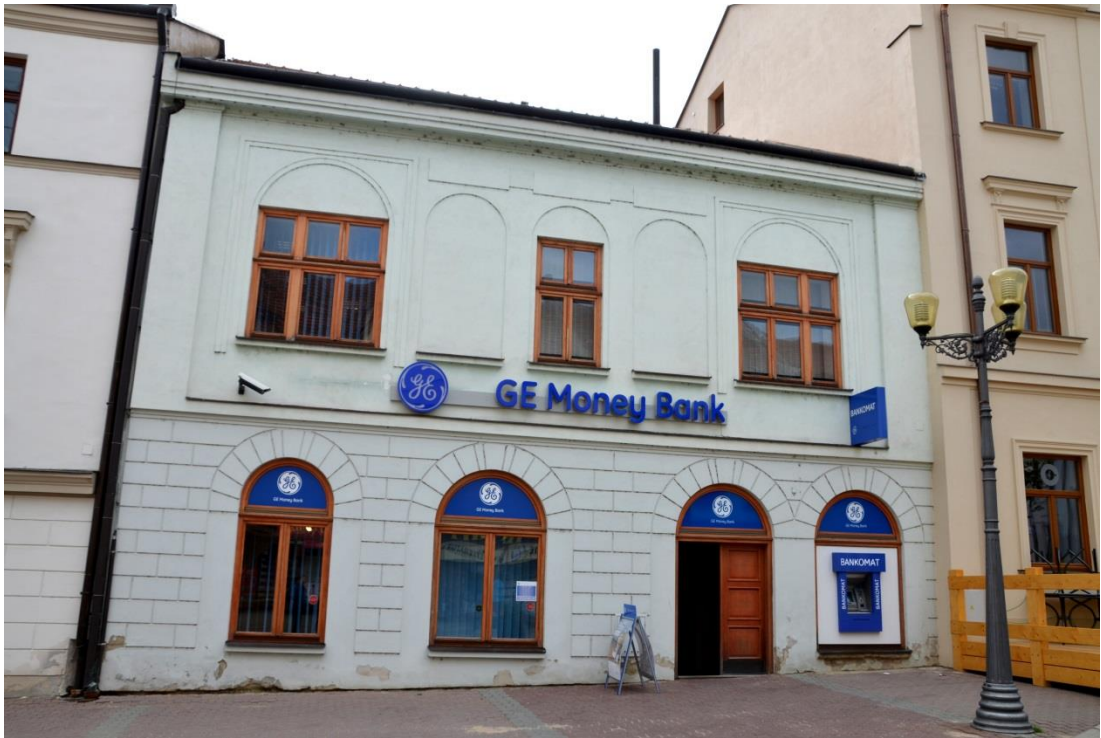
70. Průčelí měšťanského domu čp. 111
