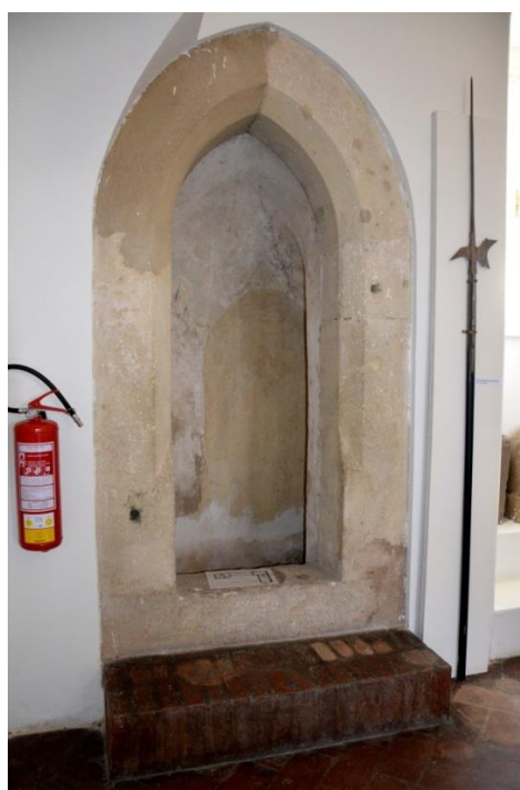
44. Pozdně gotické prvky v jedné z přízemních místností severního zámeckého křídla; lomený portál se zbytkem šnekovitého schodiště (vlevo) a odkrytá archyvola zazděného původního vchodu do místnosti (vpravo)
