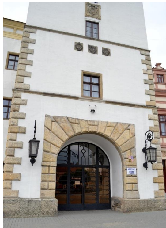
21. Průčelí hlavní radniční budovy a věže; v přízemí a prvním patře původní renesanční armování, v přízemí renesanční bosáž portálu
