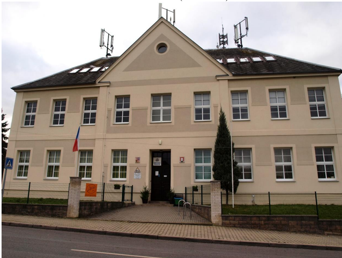
Príloha č. 39: Základná škola v Královicích (autor 2017).
