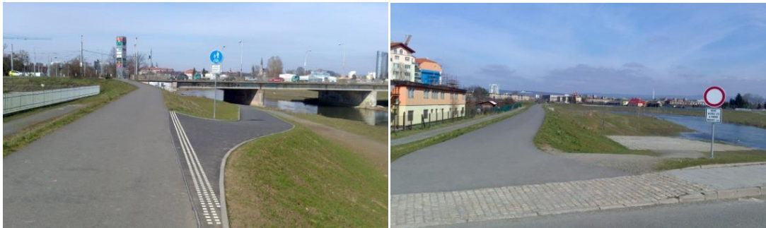
Obr. 47 a 48 Zpevněného povrchu se dočkala dříve pouze pěšinka vedoucí pod mostem na Velkomoravské ulici (vlevo). Nyní zde oficiálně vede smíšená stezka pro chodce a cyklisty se smíšeným provozem (C 9). Asfaltový pás (vpravo) v neupřesněném režimu vinoucí se od ulice U Dětského domova až k Velkomoravské ulici, po hrázi řeky Moravy, na nějž nový úsek navázal (zdroj: Haničinec, 2016).
