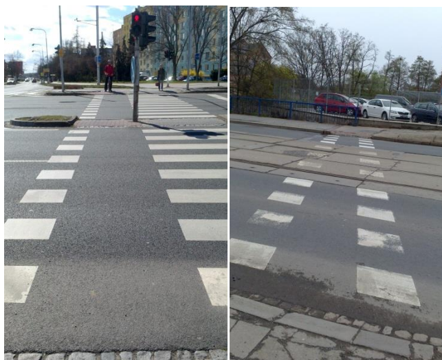
Obr. 32 a 33 Vlevo přejezd pro cyklisty přimknutý k přechodu pro chodce (V 8b) křižující Velkomoravskou ulici. Na fotografii vpravo je zachycen přejezd pro cyklisty (V 8a) křižující Hodolanskou (Haničinec, 2016).
