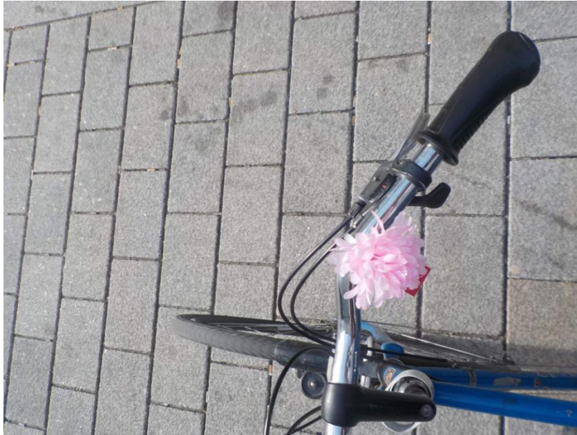
Obr. 72 Perfektně sjízdná dlažba na Mariahilferstrasse ve Vídni. Podobně komfortní úseky najdeme také v Olomouci, ale zatím je jich poskrovnu (zdroj: Filler, 2016).
