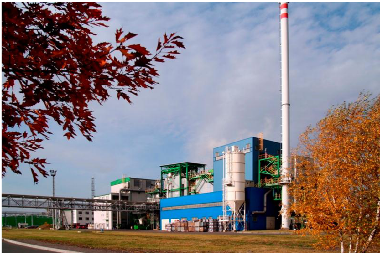
Obrázok 3. Spaľovňa nebezpečných odpadov SPOVO –Ostrava
