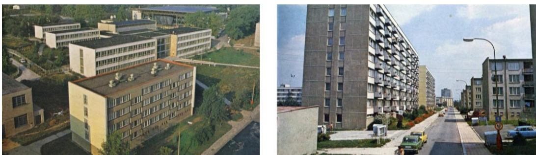
Obrázek 19: Výstavba základní školy a panelových domů v Komenské ulici. (Kroh et al. 1987)
