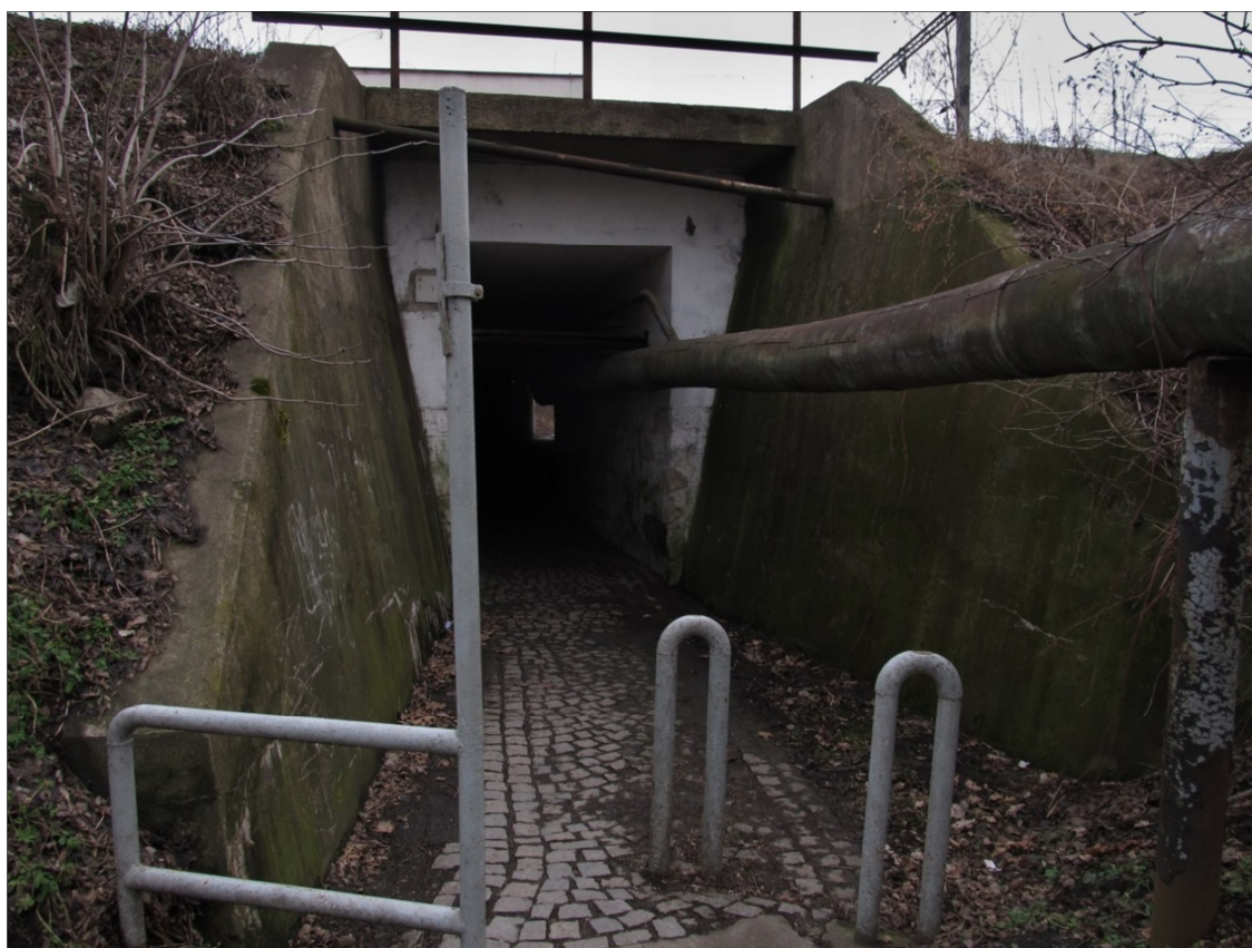
Neosvětlený podchod pod železniční tratí v Nové Vsi – potenciálně nebezpečné místo
