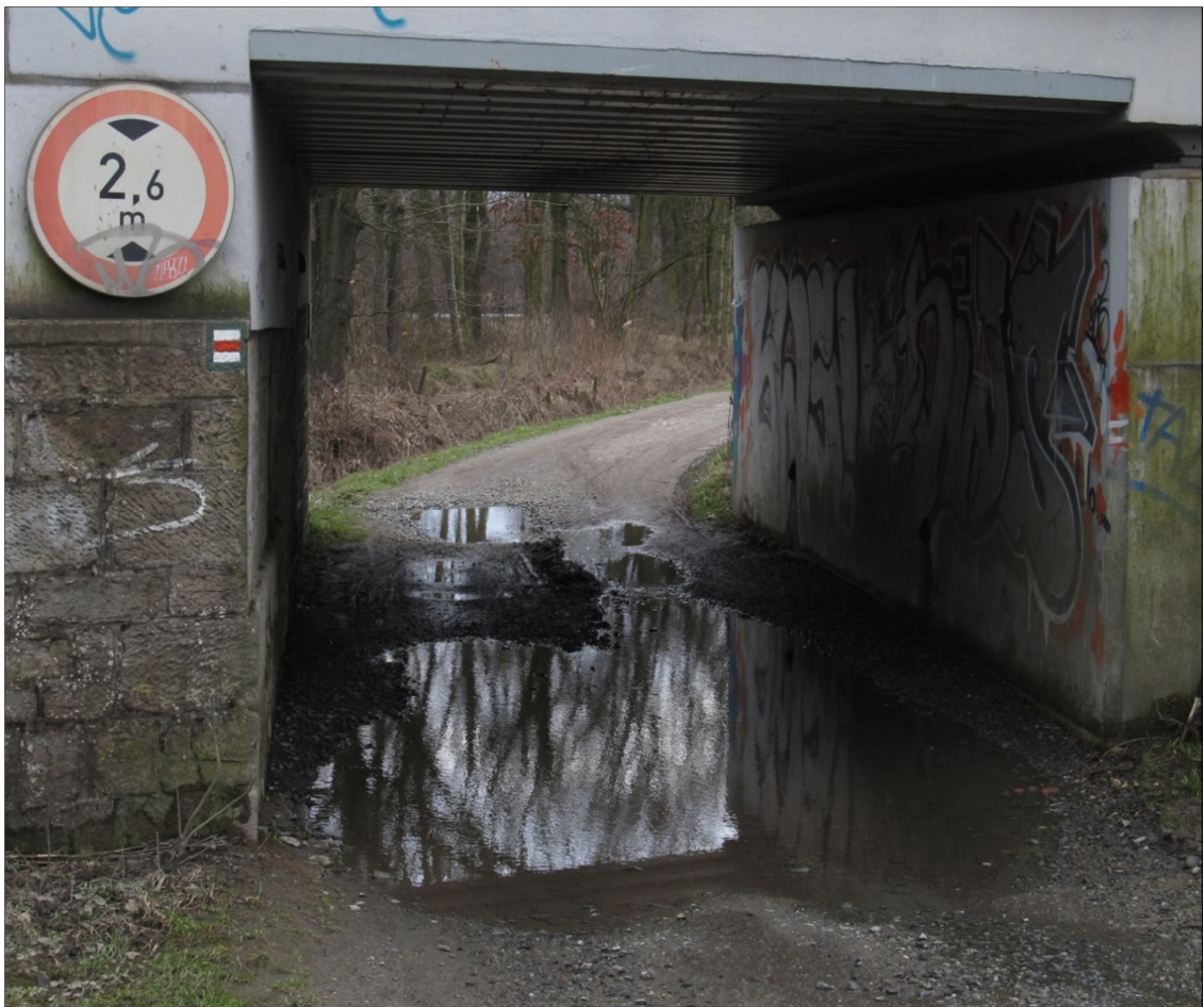
Podjezd pod železniční tratí v Polance nad Odrou
