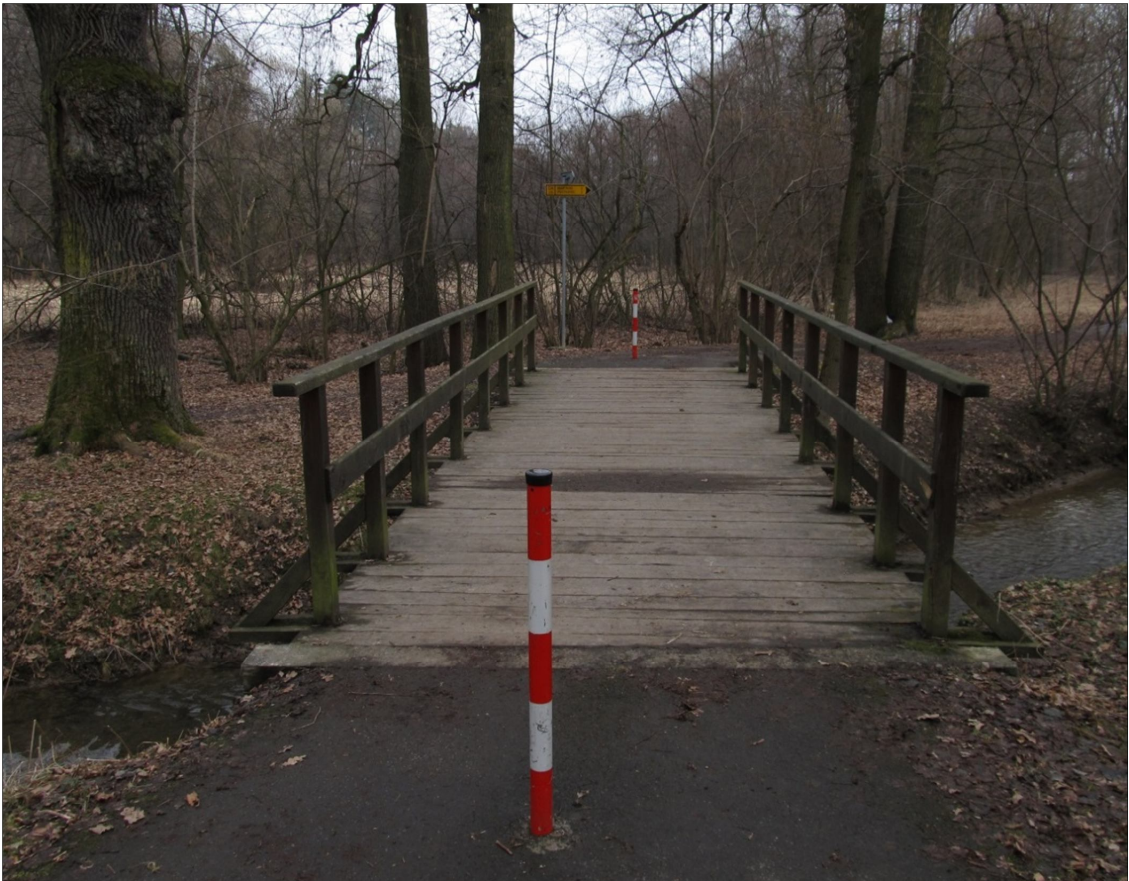
Obrázek č. X: Ocelové sloupky před dřevěným mostkem přes Plesenský potok
