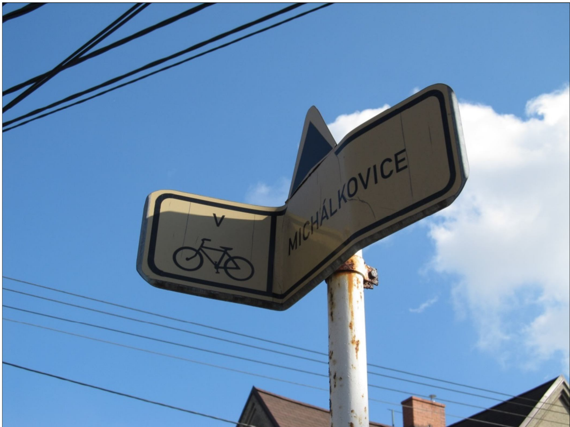
Poškozené značení cyklotrasy V na ulici Vrbická v Heřmanicích
