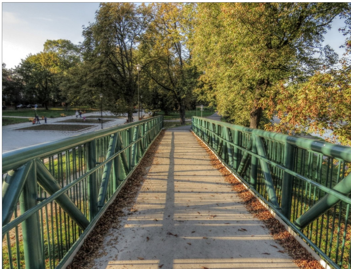
Sjezd pro cyklisty z lávky přes řeku Ostravici u budovy Nové radnice
