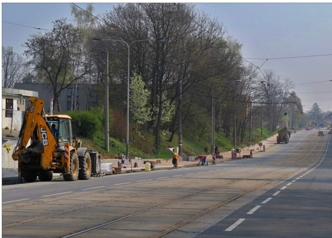
Stavební práce na stezce pro chodce a cyklisty na ulici Pavlova v Zábřehu (duben 2014)
