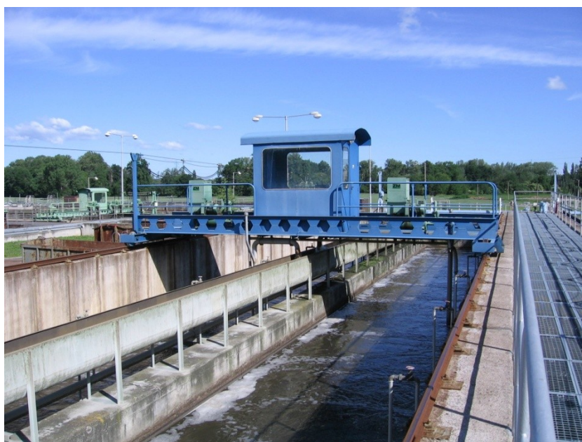
Obr. 6 - Čerpání mamutkou z lapáku písku
