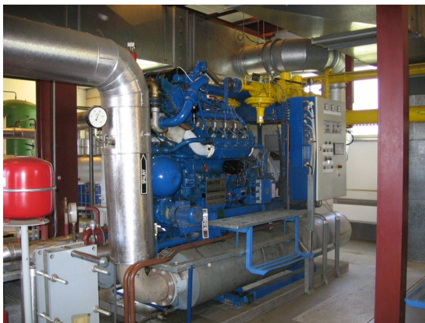
Obr. 10 - Kogenerační jednotka
