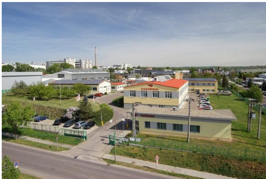
Obrázek 10: Budova společnosti (Zdroj: ELEKTROKOV, 2020)
