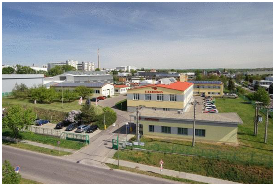
Obrázek 10: Budova společnosti (Zdroj: ELEKTROKOV, 2020)
