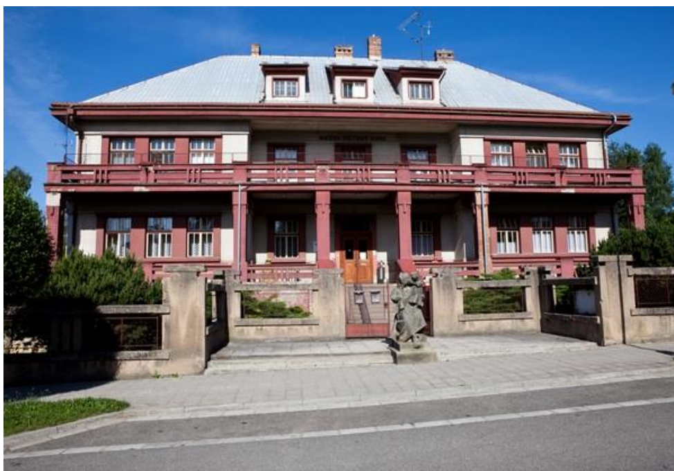
Obrázek 5 - Pohled na budovu
