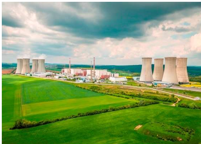
Obrázek 21 Jaderná elektrárna Dukovany [19]
