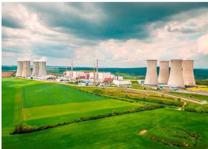
Obrázek 21 Jaderná elektrárna Dukovany [19]
