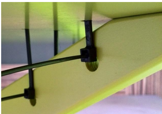
Obr. 80. Spojení stolové desky s podstavou
