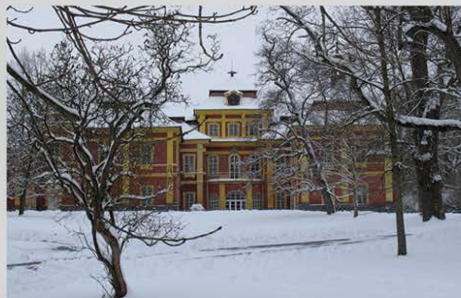
Obr. č. 69: Čestné nádvoří v zimě. (foto: autor)
