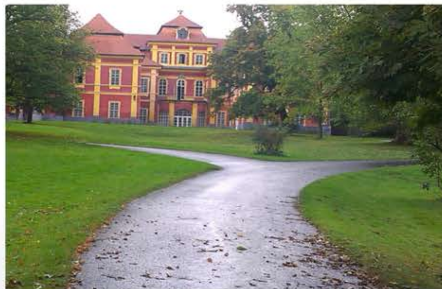
Obr. č. 72: V nejlepším pořádku je asfaltová cestní síť na ploše čestného dvora, která pokračuje po hrázi Pivovarského rybníka. (foto: autor)
