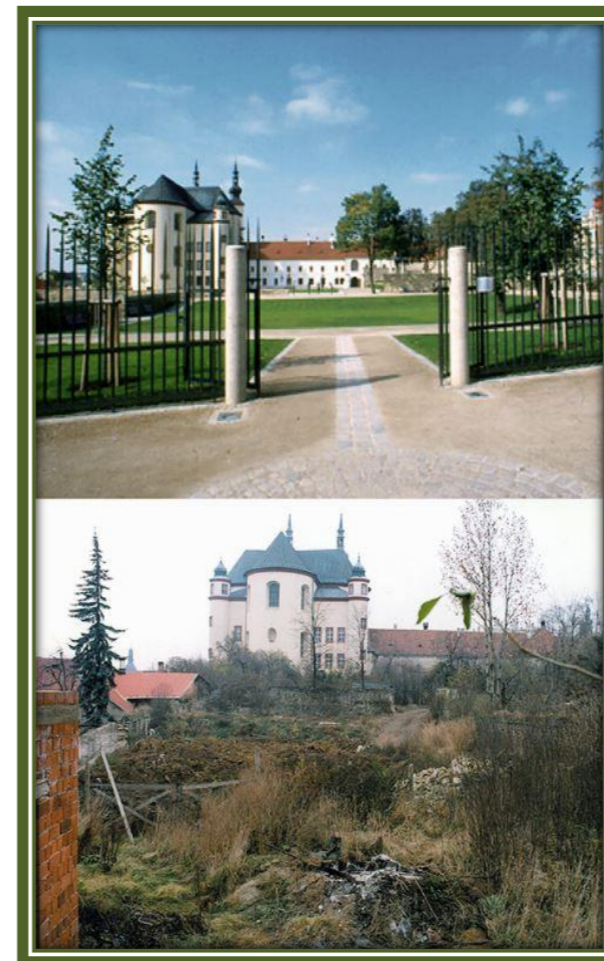
Obr. č. 3: Fotodokumentace zahrady před a po realizaci (www.archiweb.cz).
