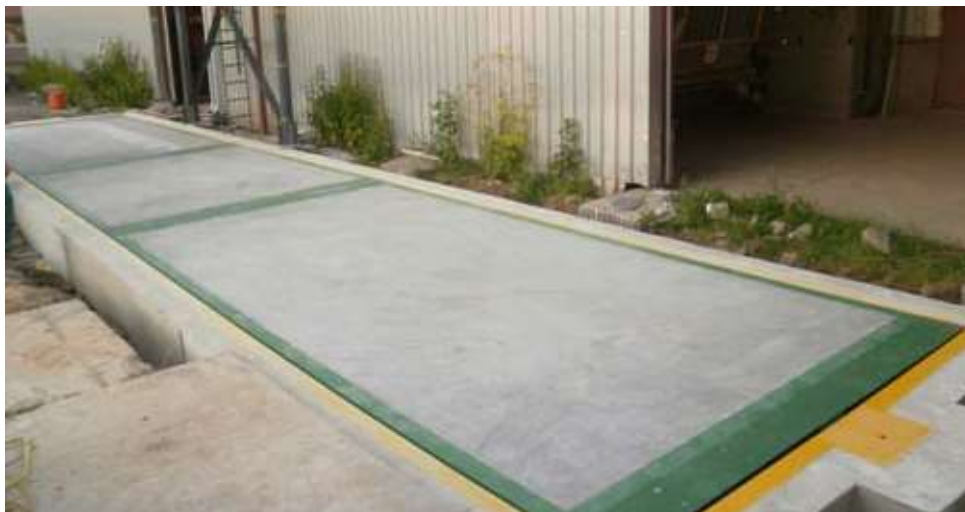
Obr. 8 Zabudovaná mostní váha v blocích (B)
