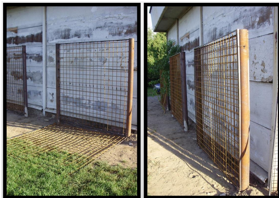
Obr. 86: Stavba konstrukce vertikální stěny. Foto: Matiska, 2013.
