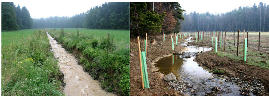
Obr. 9 Revitalizace Pekelského potoka, vlevo: původní technicky upravené koryto (2005), vpravo: vytvořeno nové přírodě blízké koryto (2006)
