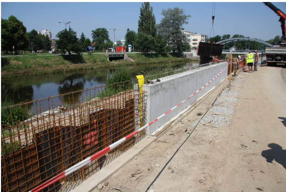
Obr. 3 Výstavba nových protipovodňových zábran na Nežárce ve Veselí nad Lužnicí
