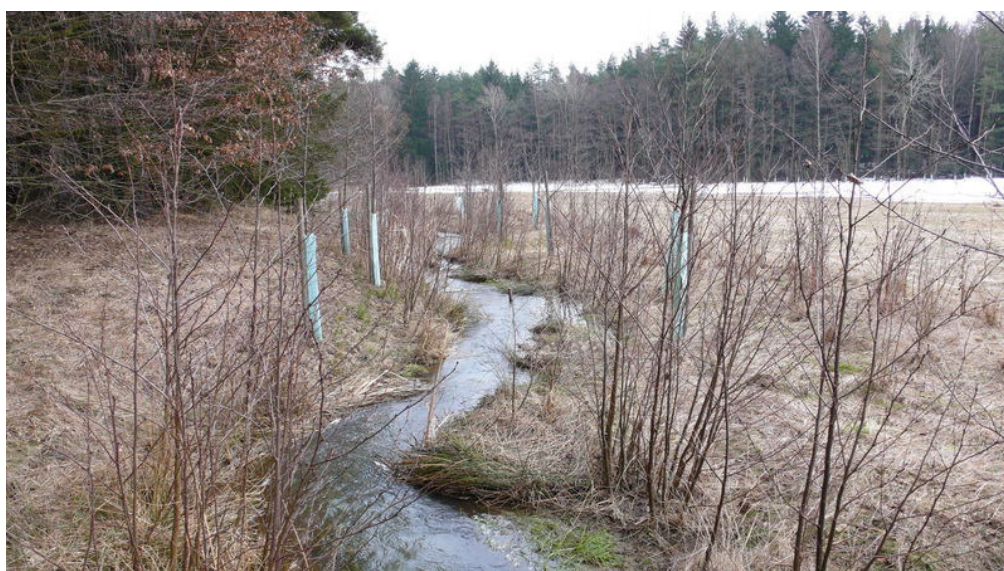
Obr. 10 Revitalizace Pekelského potoka po třech letech od jejího dokončení (2009)
