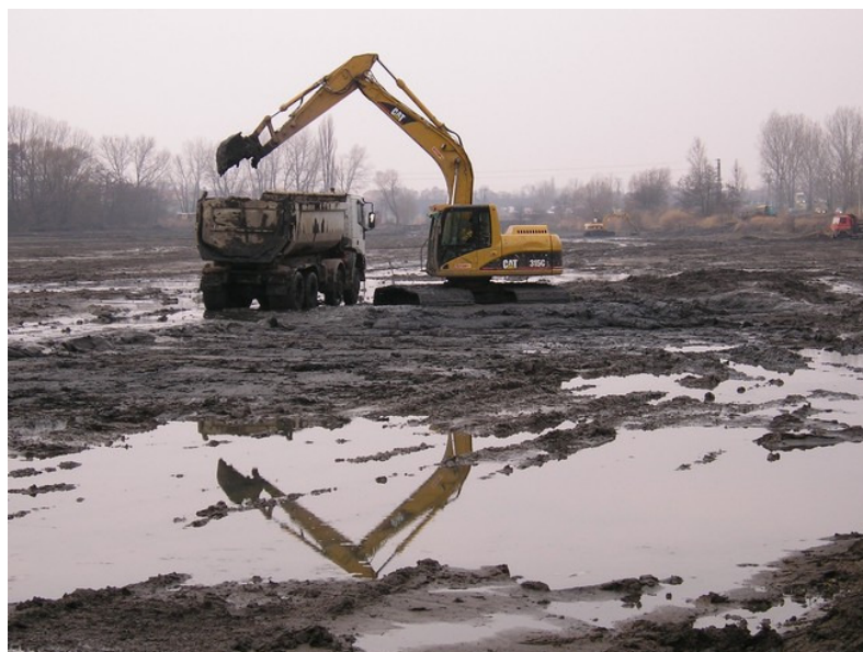
Obr. 4 Odbahnění rybníka Strnad sloužícího jako retenční nádrž v Hostivicích
