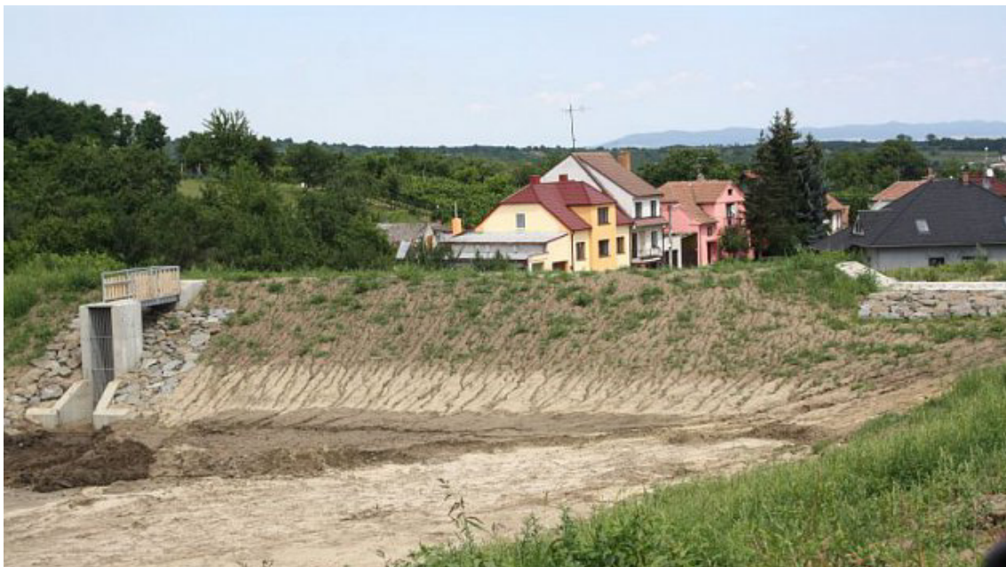
Obr. 2 Výstavba suché nádrže (poldru) v obci Loděnice v povodí Odry
