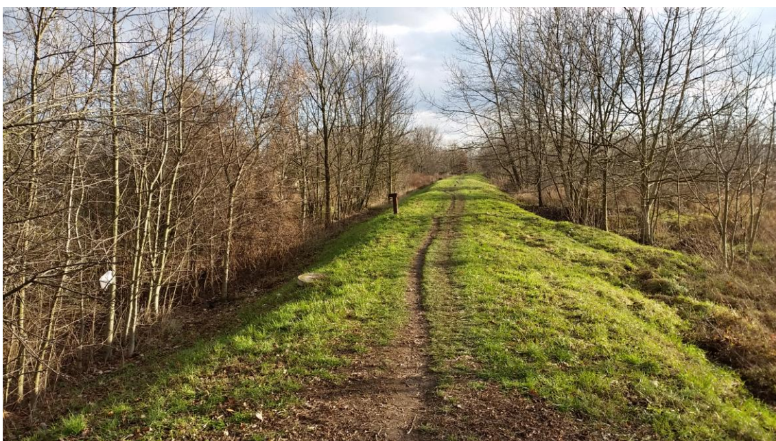
Foto 14 Zemní hráz u ČOV (autor, 13.12.2017)
