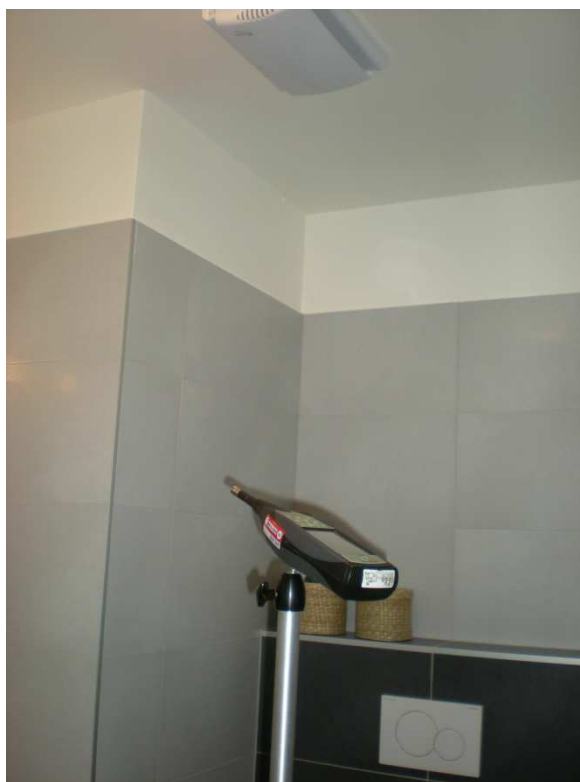
Obr. 13 Ukázka jednoho z měřených prostorů s ventilátorem
