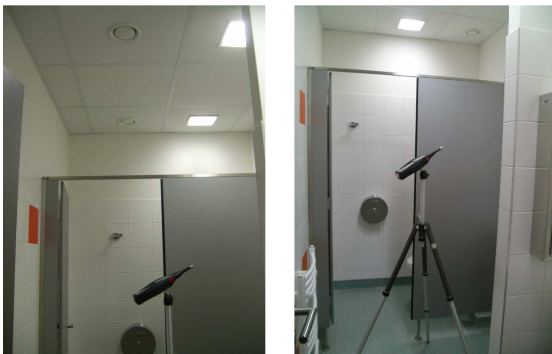
Obr. 8 Totožné hygienické prostory s rozdílným umístěním talířových ventilů
