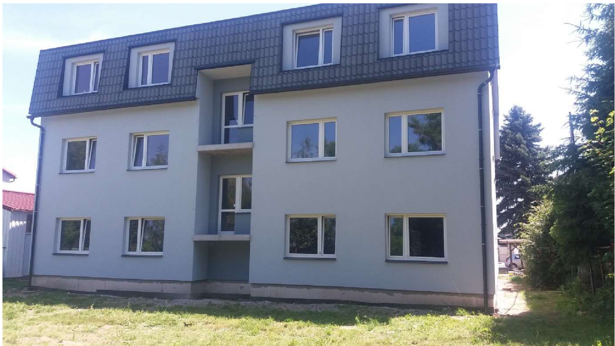
Obrázek č. 5 – bytový dům v Mladých Bukách
