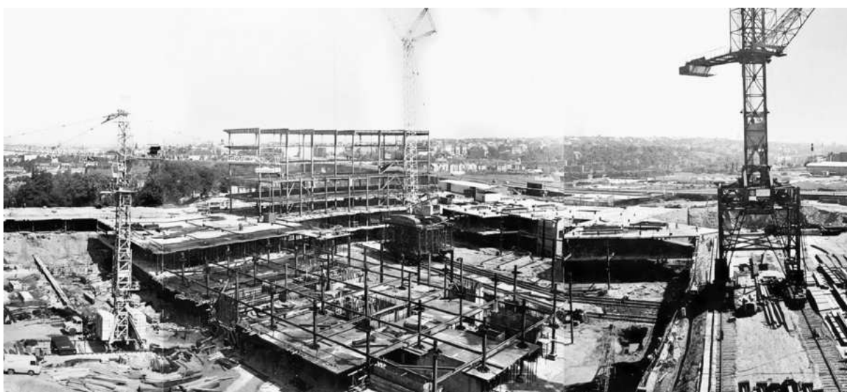
Obr. 55/ Montáž ocelové konstrukce Paláce kultury, červenec 1977
