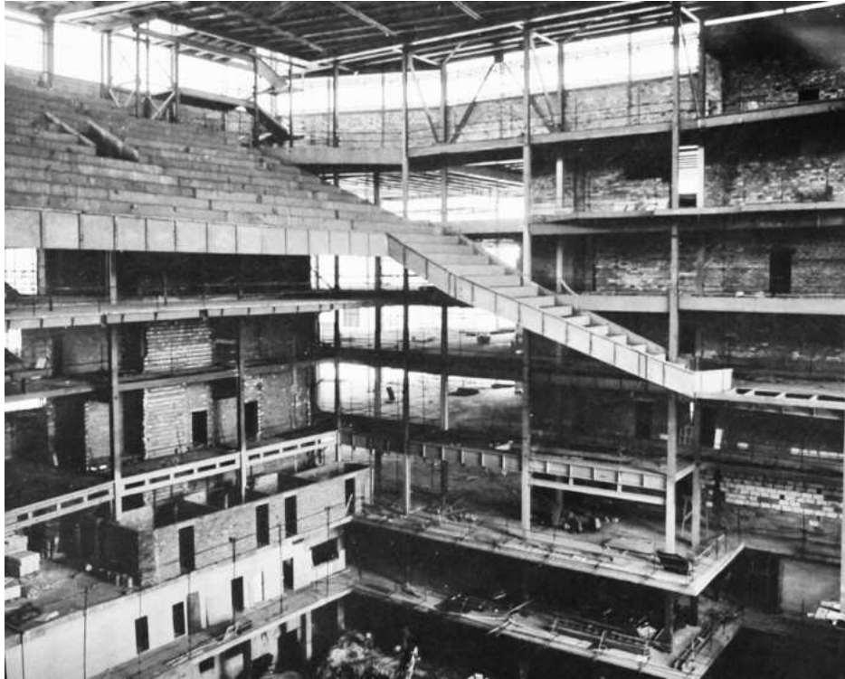
Obr. 56/ Sjezdový sál Paláce kultury ve výstavbě, prosinec 1977
