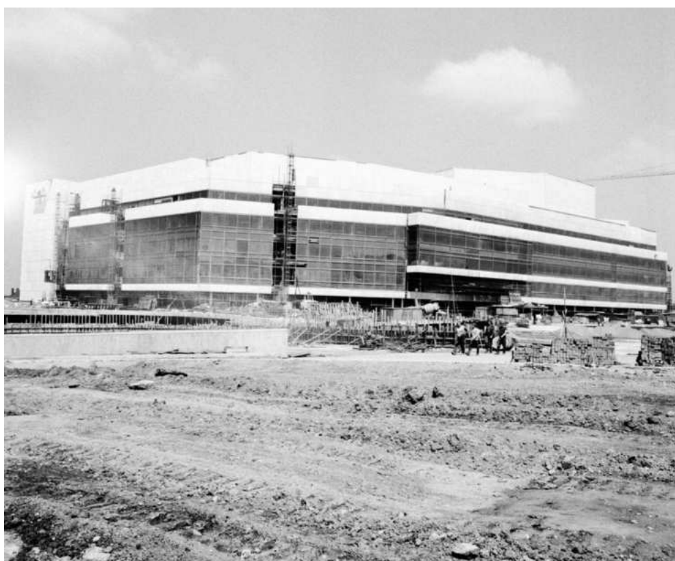
Obr. 59/ Staveniště Paláce kultury před dokončením
