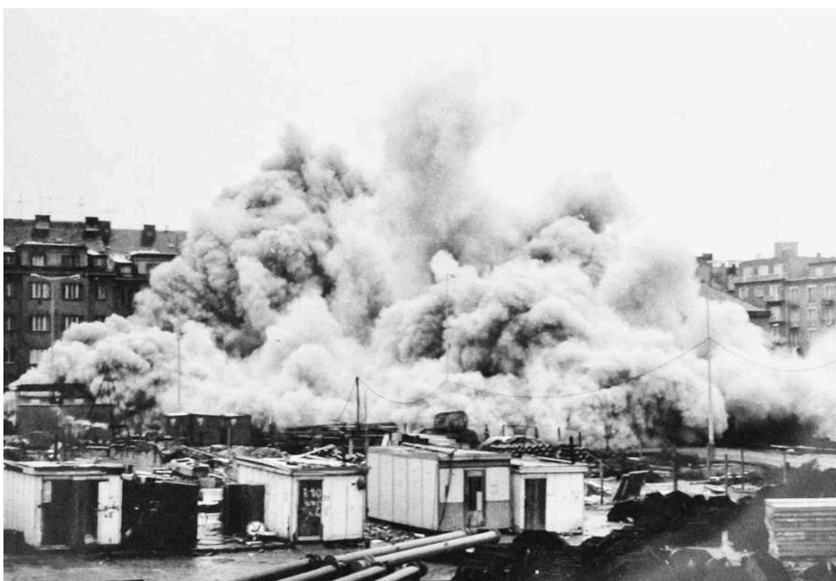
Obr. 52/ Praha, Demolice budovy zázemí stavařů a projektantů Paláce kultury, 24. dubna 1980
