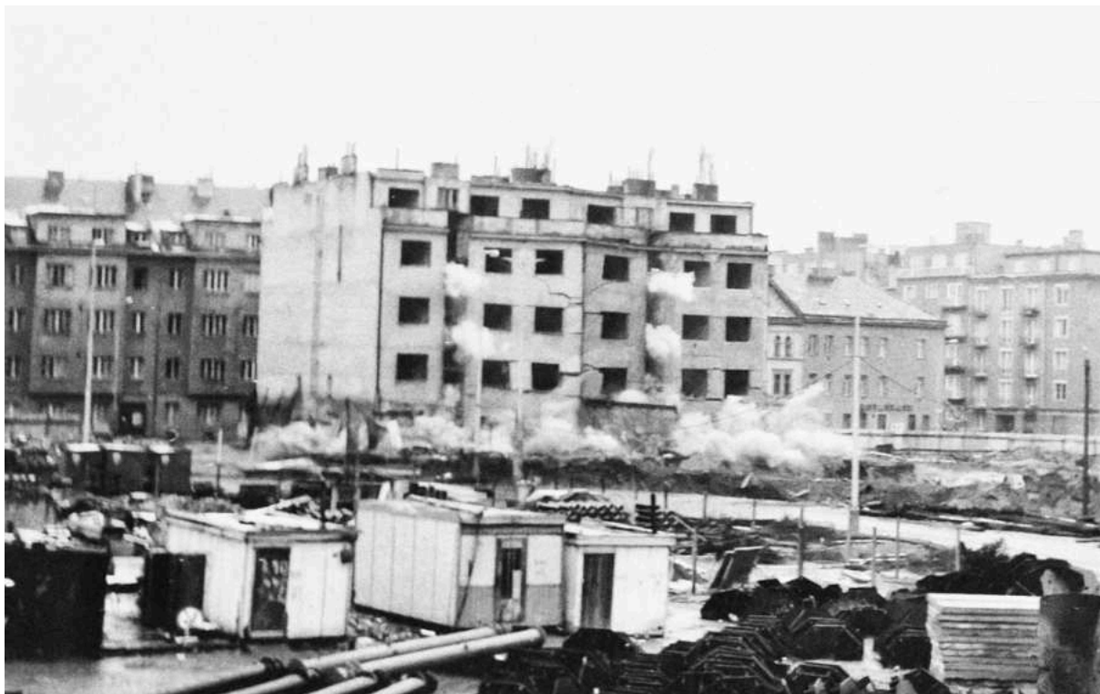
Obr. 51/ Praha, Demolice budovy zázemí stavařů a projektantů Paláce kultury, 24. dubna 1980
