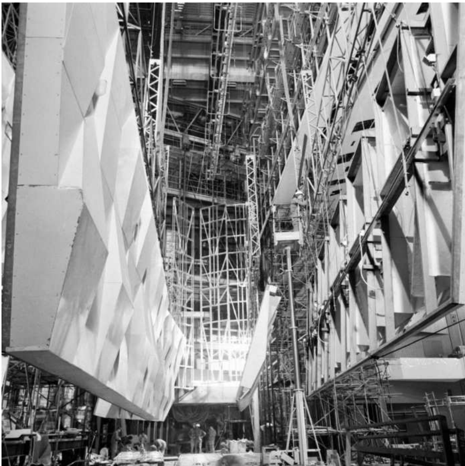
Obr. 57/ Průběh úprav jeviště Sjezdového sálu Paláce kultury
