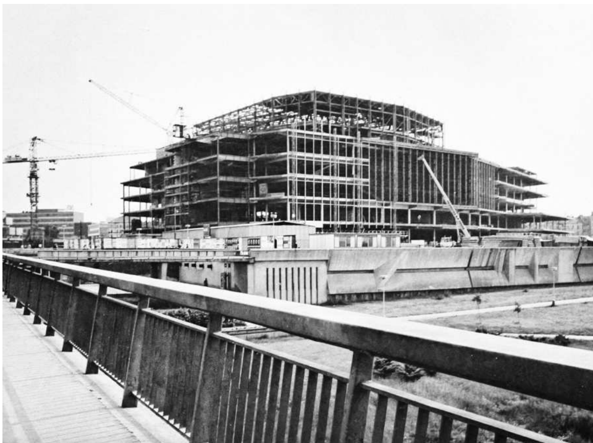
Obr. 58/ Konstrukce Paláce kultury před jejím dokončením, pohled z mostu Klementa Gottwalda
