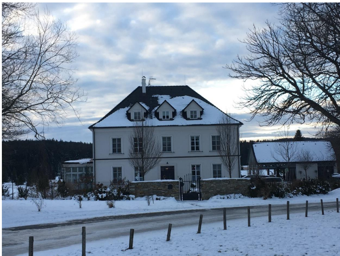
Příloha 4 Nově postavená fara, prosinec 2020 (autor fotografie: O. Matyš)
