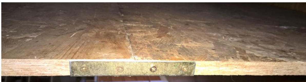
Obrázek 16 - spoj OSB desek, zatím bez příček avšak již nyní jsou spojené lepidlem Mamut a ocelovými pásnicemi
