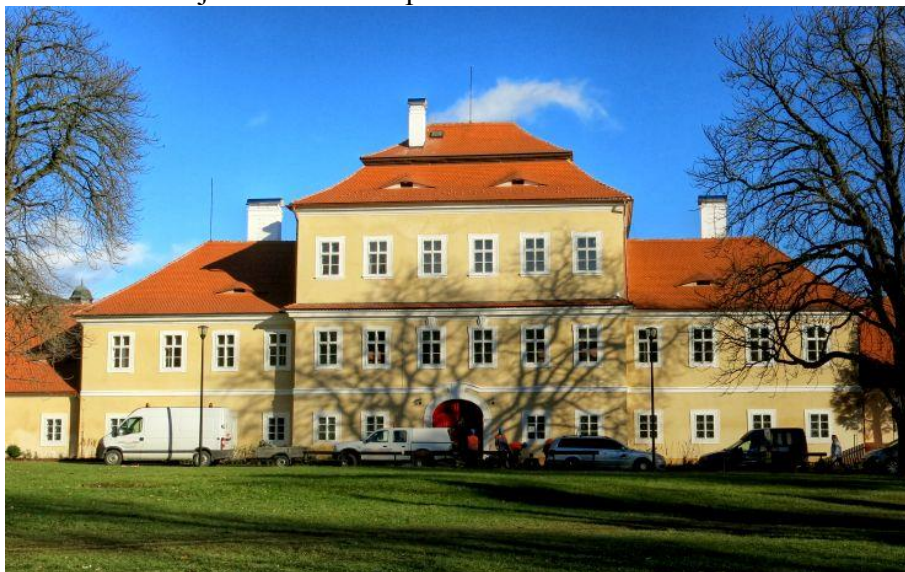
Zámek Valdštejnů v Litvínově po rozsáhlé rekonstrukci
