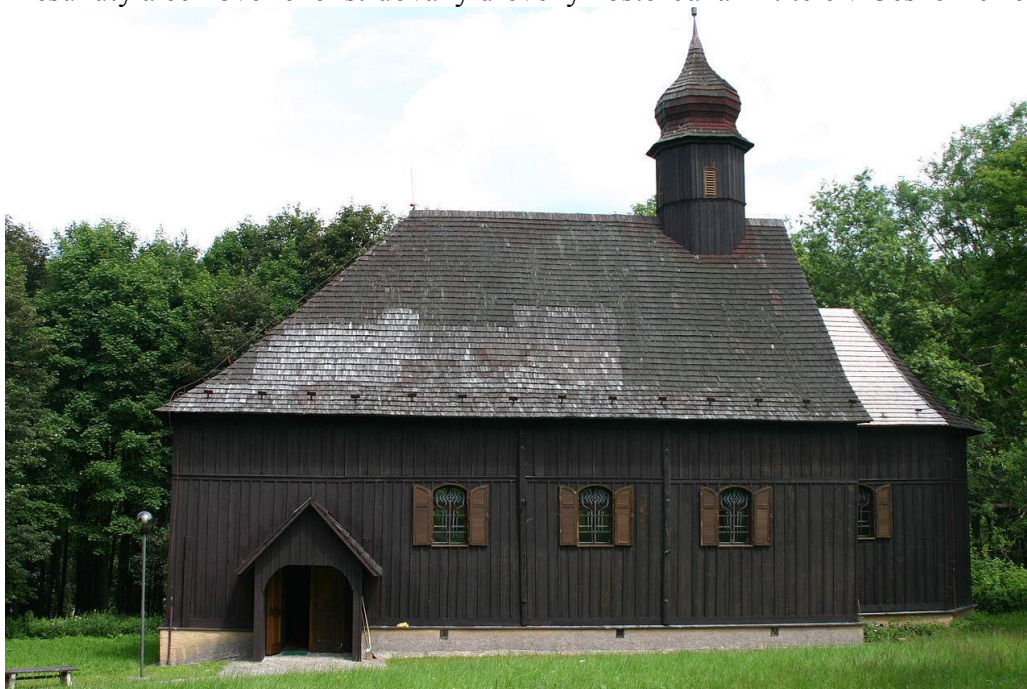
Přesunutý a celkově rekonstruovaný dřevěný kostel Jana Křtitele v Českém Jiřetíně
