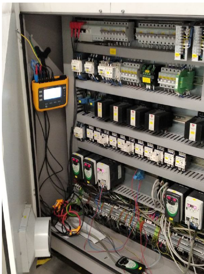
Obr. 3.5: Pripojený záznamník Fluke 1738 na spájkovaciu vlnu
